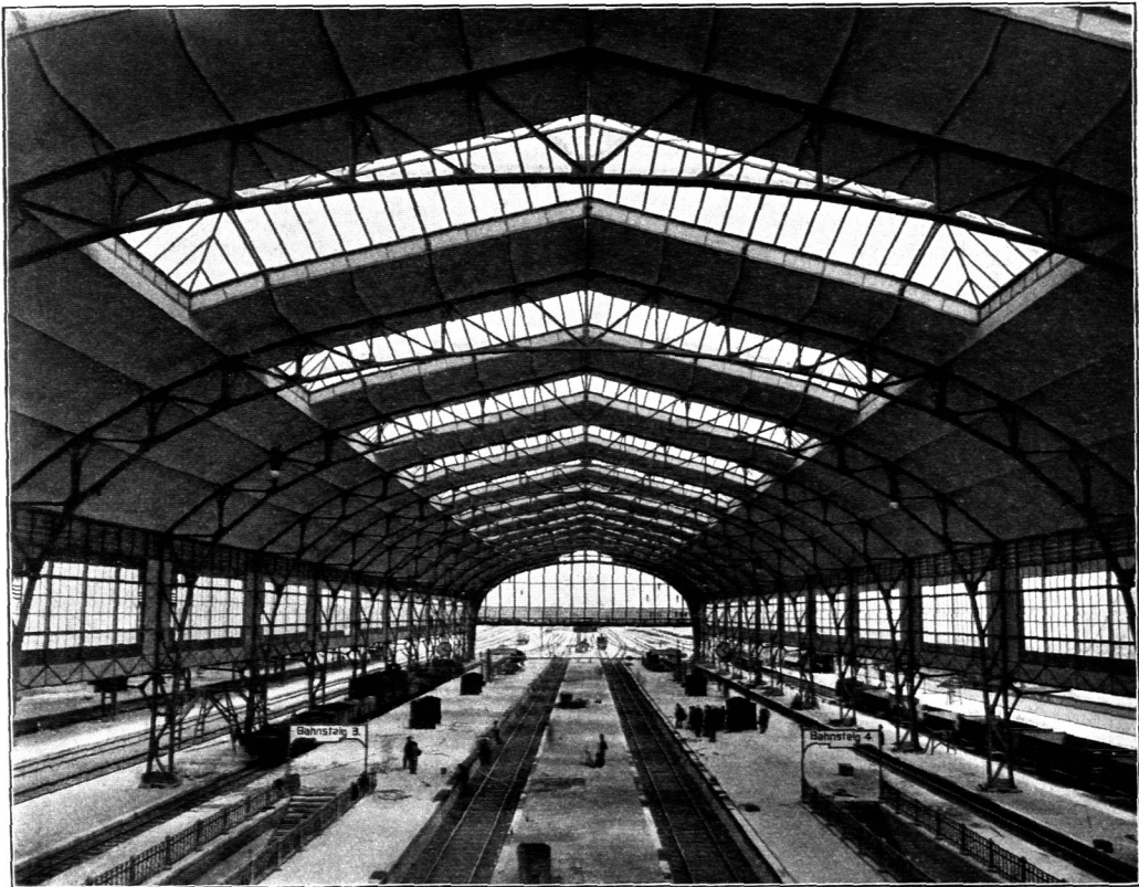
Inneres der Bahnsteighalle auf dem Hauptbahnhof zu Metz.
