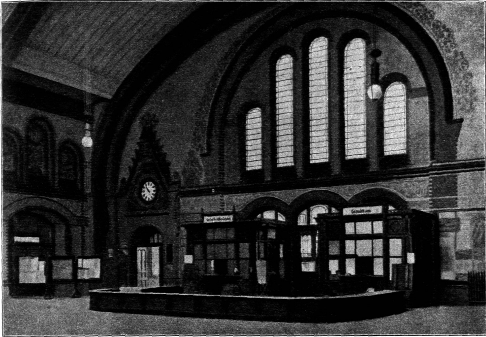
Eingangshalle mit Gepäckannahme im Empfangsgebäude des Bahnhofes zu Altona 61) .
