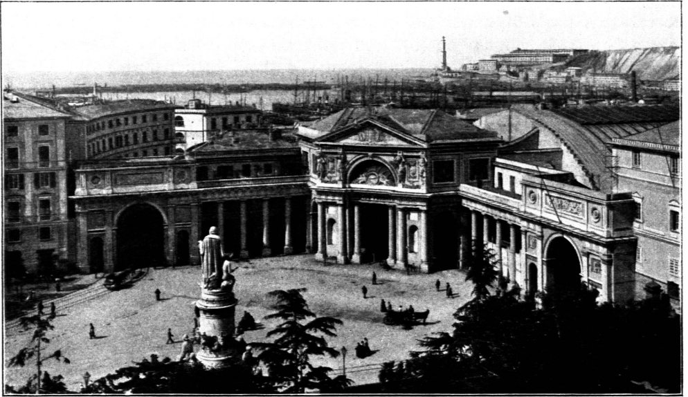
Empfangsgebäude des Bahnhofes zu Genua. (Inzwischen erweitert worden.)
