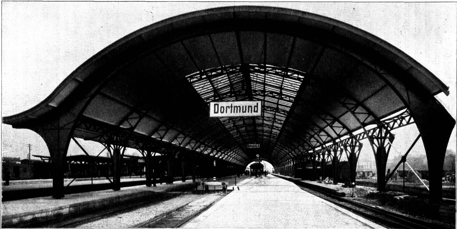
Bahnsteighalle auf dem Bahnhof zu Dortmund.
