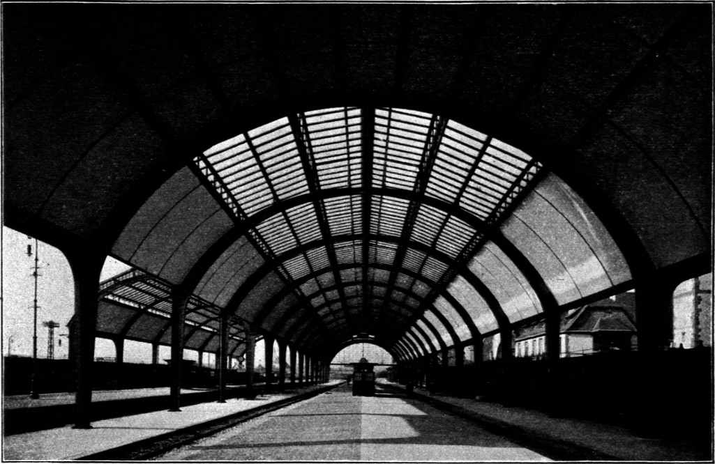
Bahnsteighalle auf dem Bahnhof zu Homburg v. d. H.
