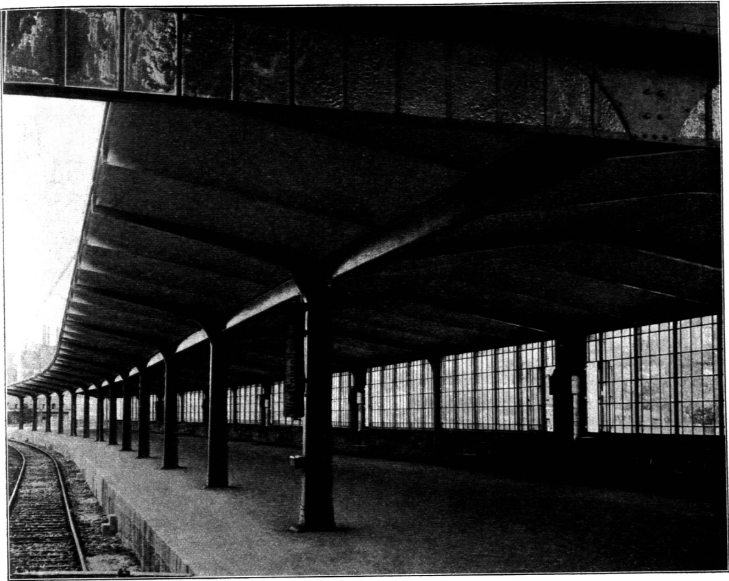
Überdachung der Wiesbadener Bahnsteige auf dem Hauptbahnhof zu Mainz.
