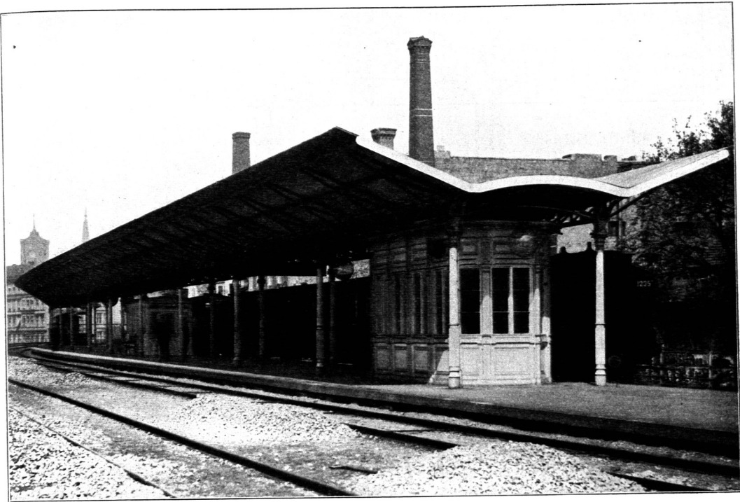
Zwischenbahnsteigdach der Berliner Stadt-Eisenbahn, Haltestelle Jannowitzbrücke.
