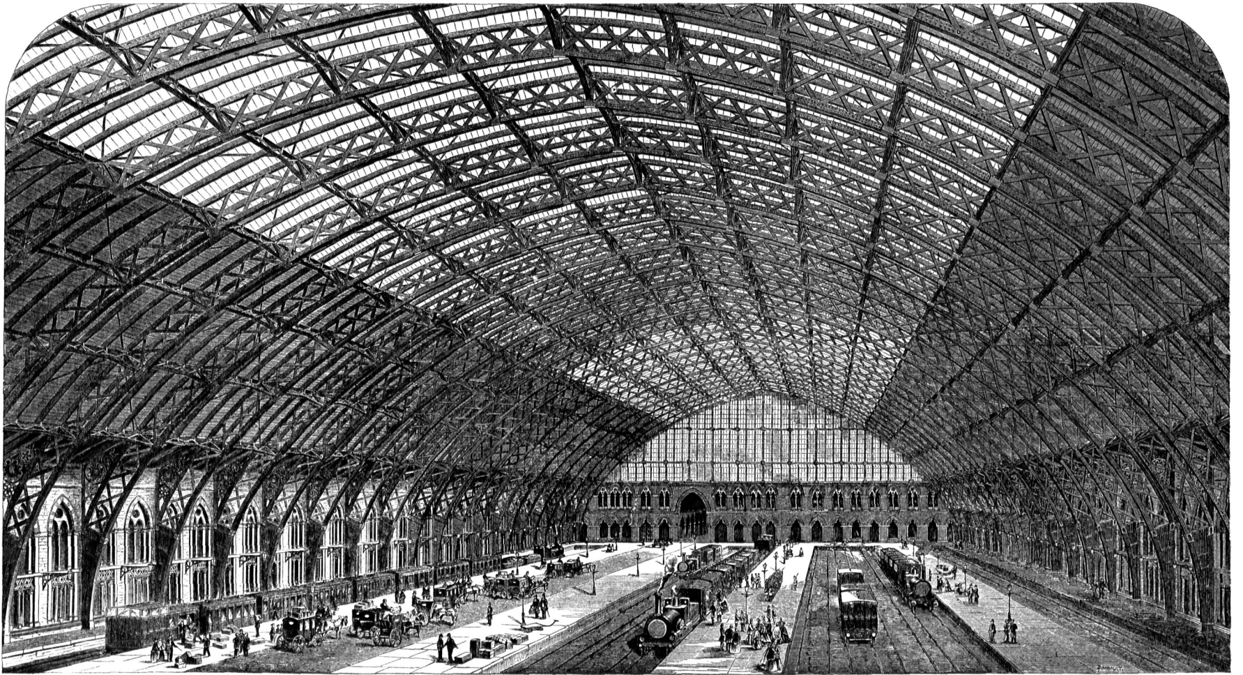
Inneres der Bahnsteighalle auf der St. Pancras-Station der Midland-Eisenbahn zu London 58).
