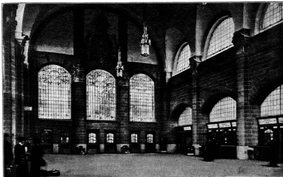
Eingangshalle im Empfangsgebäude des Bahnhofes zu Wiesbaden.
