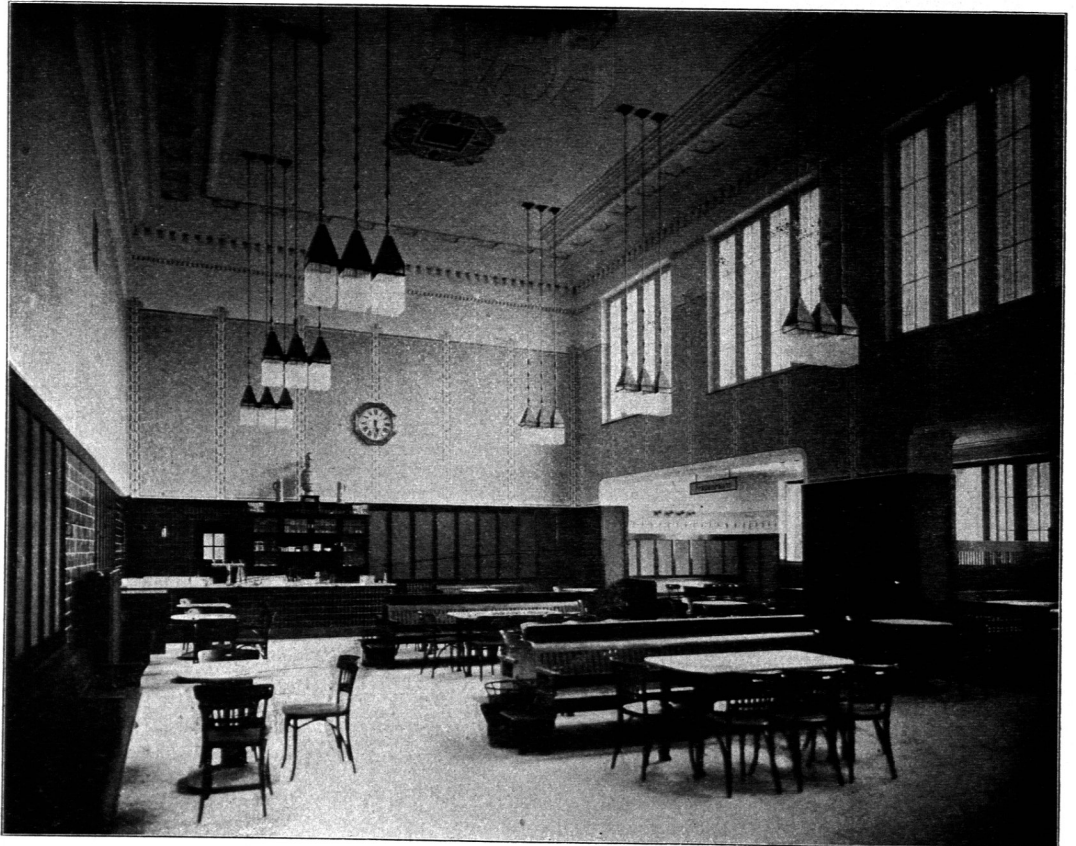
Wartesaal und Erfrischungsraum III. u. IV. Klasse im Empfangsgebäude des Bahnhofes zu Mülheim a. Rh.
