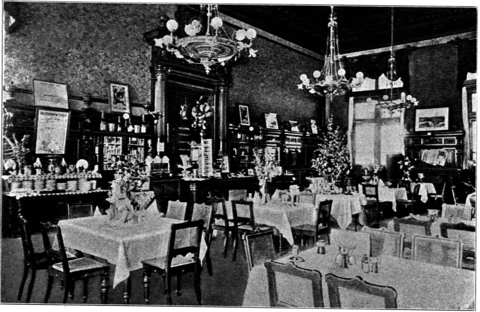
Wartesaal und Erfrischungsraum I. und II. Klasse im Empfangsgebäude des Hauptbahnhofes zu Mainz.
