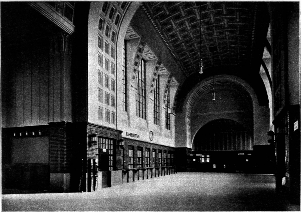
Eingangshalle im Empfangsgebäude des Bahnhofes zu Mülheim a. Rh.
