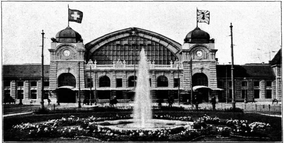
Empfangsgebäude des neuen Bahnhofes der schweizerischen Bundesbahnen zu Basel.
