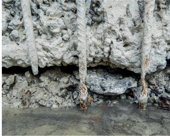
Abb. 67: Links: skizzenhafte Darstellung des problematischen Bereichs Fundament - Wand; Rechts: freigelegte Hauptbewehrung einer Winkelstützmauer (ASTRA, 2014)
