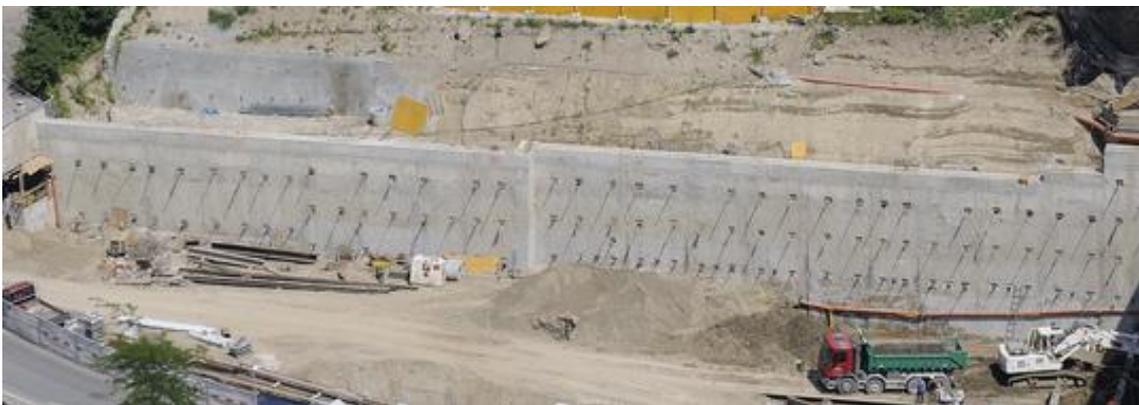
Abb. 23: Beispiel einer Schlitzwand mit nachträglicher Verankerung (Implenia GmbH, 2012)
