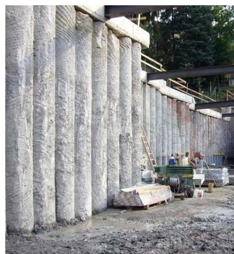
Abb. 26: Beispiel einer Bohrpfahlwand (Bachner GmbH, 2006)
