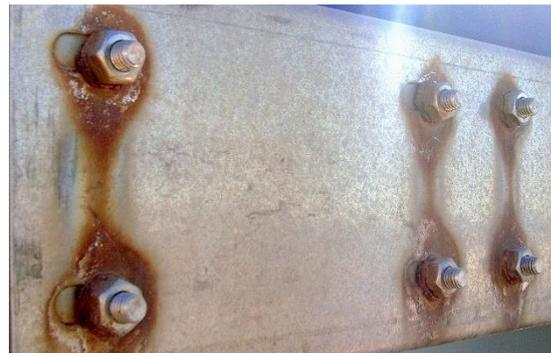
Abb. 62: Beispiel einer Kontaktkorrosion (TH Leipzig, 2010)
