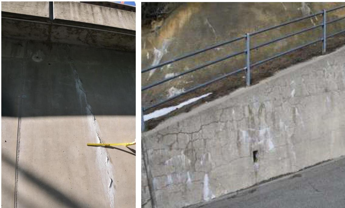
Abb. 47: Links: Betonausblühung in der Nähe eines Risses im Stahlbetonbauteil;
