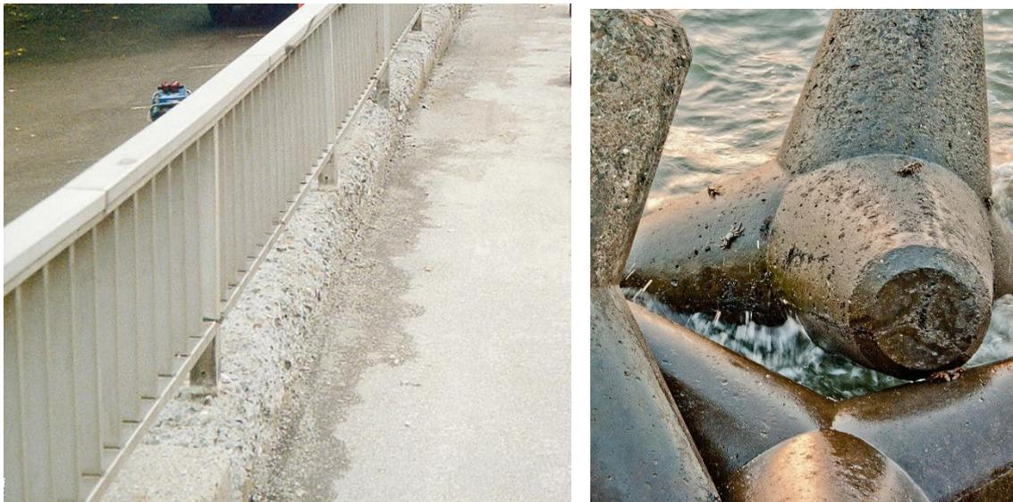
Abb. 48: Beispiele einer Schädigung durch Betonkorrosion (Baustoffwissen, 2016)
