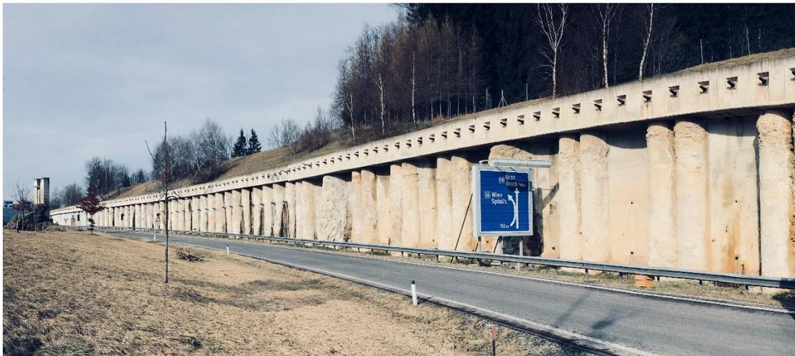
Abb. 6: Beispiel einer Stützwand in Form einer Pfahlwand mit verankerten Kopfbalken
