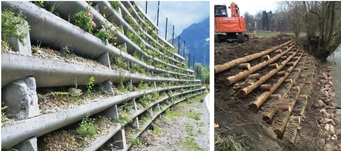
Abb. 16: Beispiele von Raumgitterwänden; Links: Fertigteile aus Stahlbeton; Rechts: Krainerwand (Weidenart GmbH, 2014)
