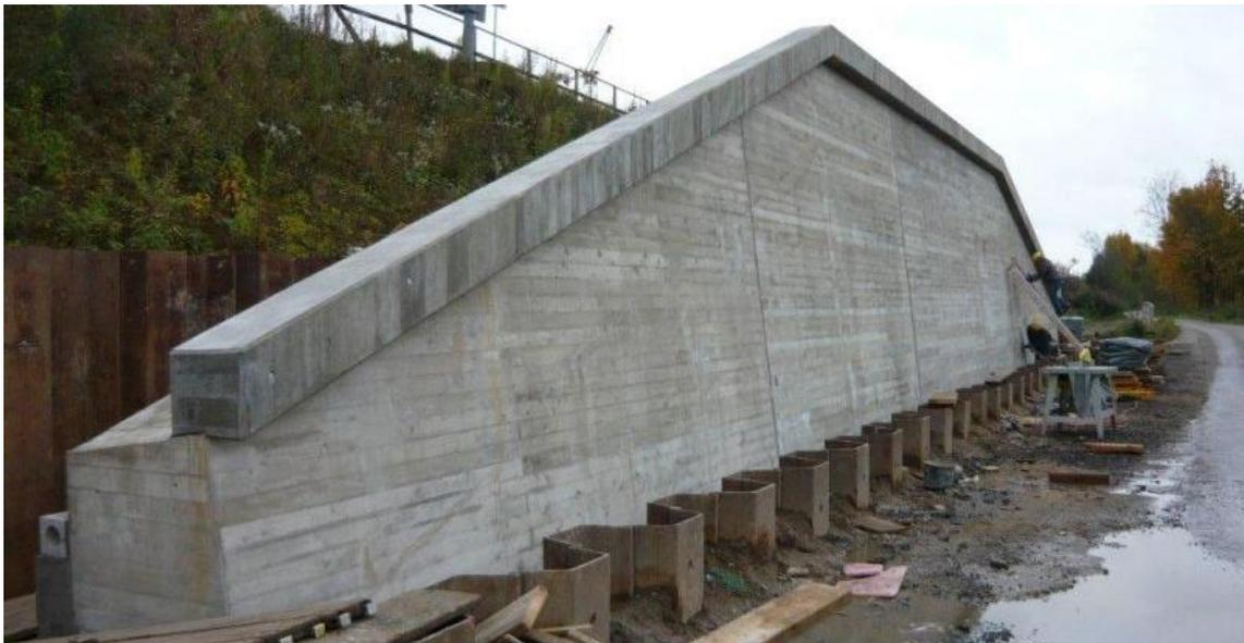
Abb. 5: Neubau einer Stützmauer (Ritter-Bau GmbH, 2011)
