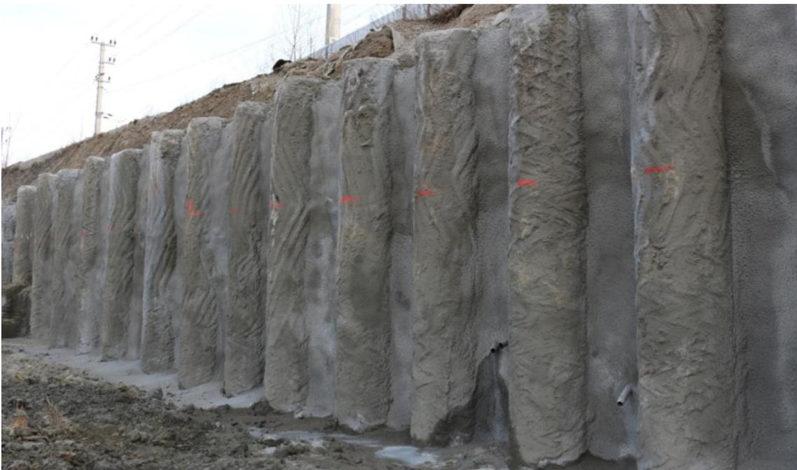
Abb. 7: Beispiel einer Stützwand in Form einer ungeankerten Pfahlwand
