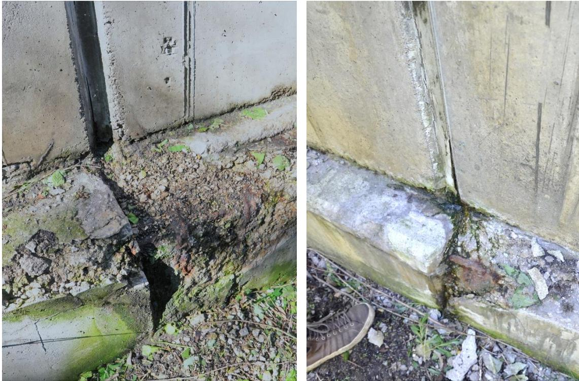
Abb. 45: Beispiel einer Betonabplatzung an einem Stützmauerfundament
