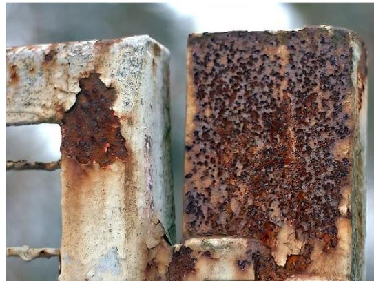
Abb. 61: Beispiel einer Muldenkorrosion (TH Leipzig, 2010)
