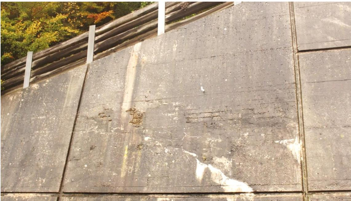
Abb. 46: Beispiel einer Betonabplatzung an der Wandoberfläche eines Stützbauwerks
