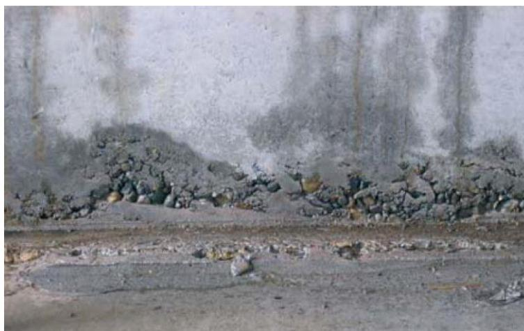
Abb. 51: Beispiel eines eingebauten Kiesnestes (Holcim, 2011)
