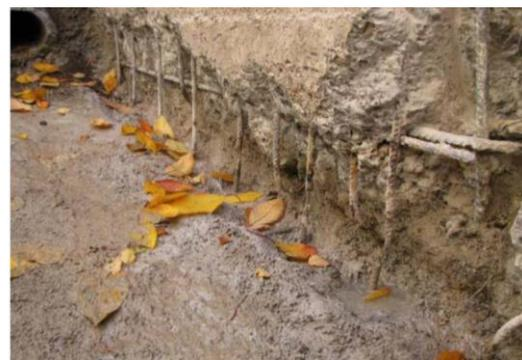
Abb. 68: Korrosionsgeschädigte Biegezugbewehrung einer Winkelstützmauer (Geotechnik Schweiz, 2017)
