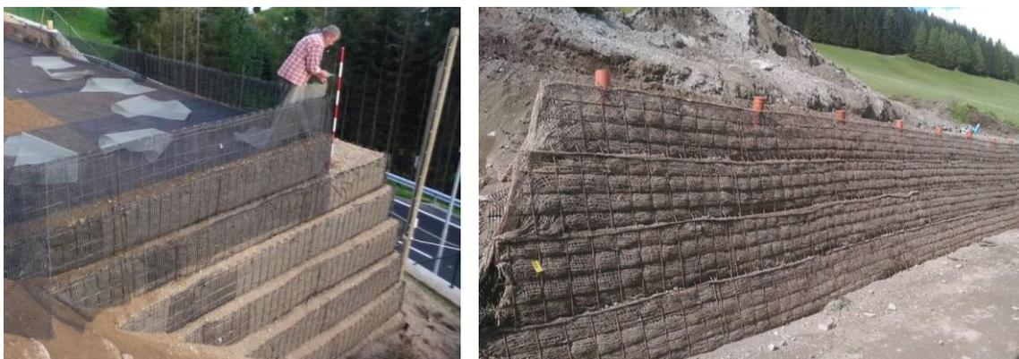
Abb. 21: Beispiele einer bewehrten Erde Konstruktion (Schartmüller GmbH)
