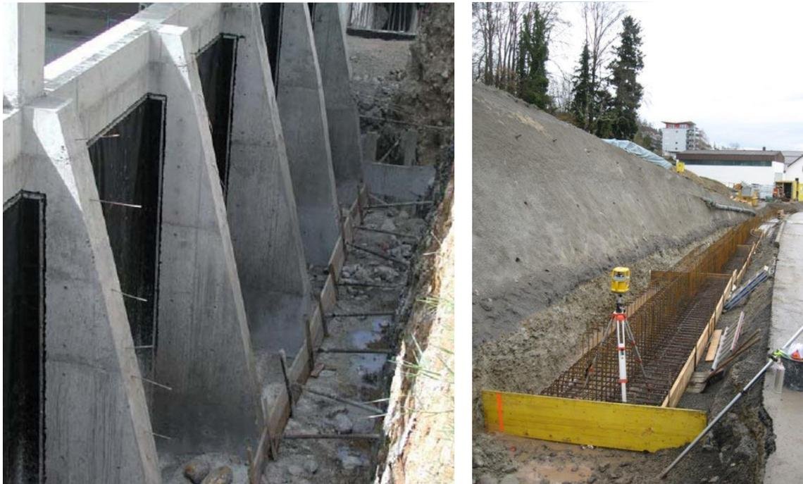
Abb. 33: Beispiele einer Winkelstützmauer; Links: aussteifende Rippen „Schwerter“; Rechts: Fundamentbewehrung einer Winkelstützmauer (BSP Ingenieure, 2013)
