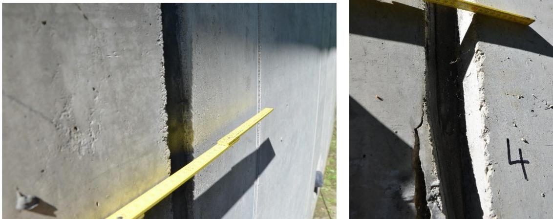
Abb. 53: Beispiel eines Versatzes an einer bestehenden Stützmauer
