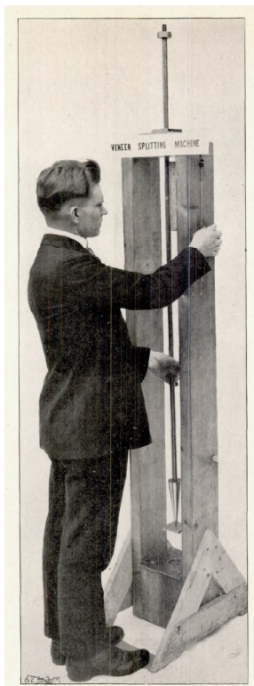
Abbildung 6.5: Spaltversuch (Elmendorf, 1920)
