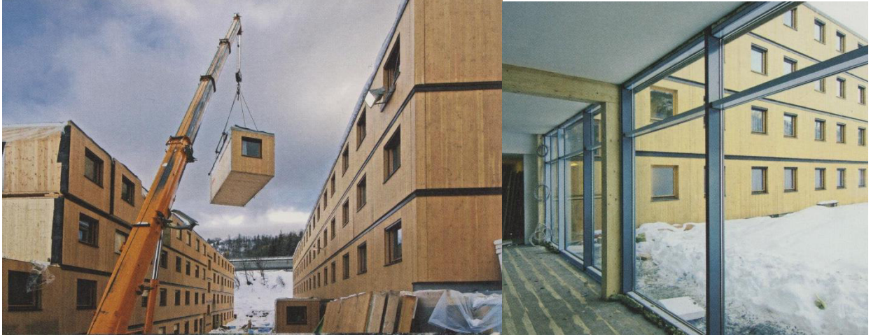
Abbildung 2-34: Montage der Raumzellen (links), aus Raumzellen zusammengesetztes Gebäude vor dem Innenausbau (rechts) [20]
