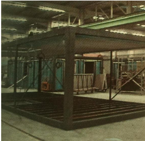
Abbildung 2-29: tragender Rahmen mit Aussteifungsdiagonalen und Bodenkonstruktion (links), Typen von Raumzellen: offene Zelle (Mitte oben), zweiseitig offen (oben rechts), einseitig offen (Mitte unten) und Vollzelle (unten rechts) [16]
