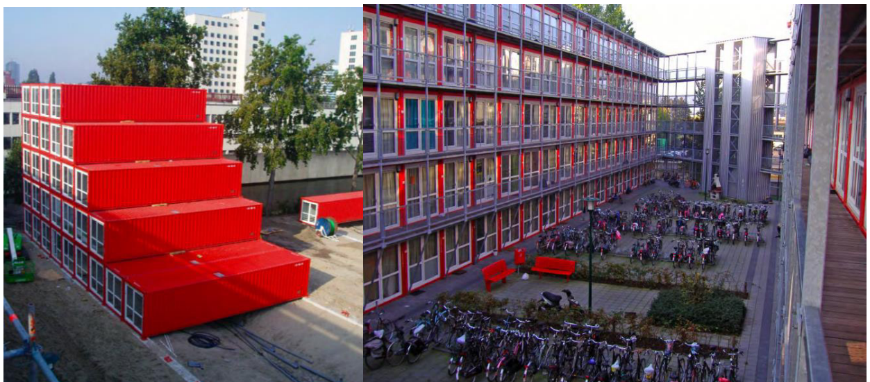
Abbildung 2-32: Container im Bauzustand (links), Blick in den Innenhof des Studentenheims (rechts) [19]
