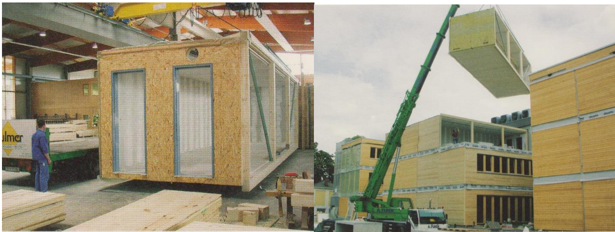
Abbildung 2-33: Fertigung der Raumzellen im Werk (links) und Montage auf der Baustelle (rechts) [20]
