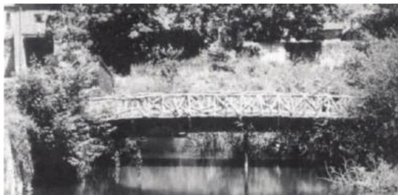
Abbildung 9 Erste Stahlbetonbrücke beim Landsitz Chazelet [10, p. 6]
