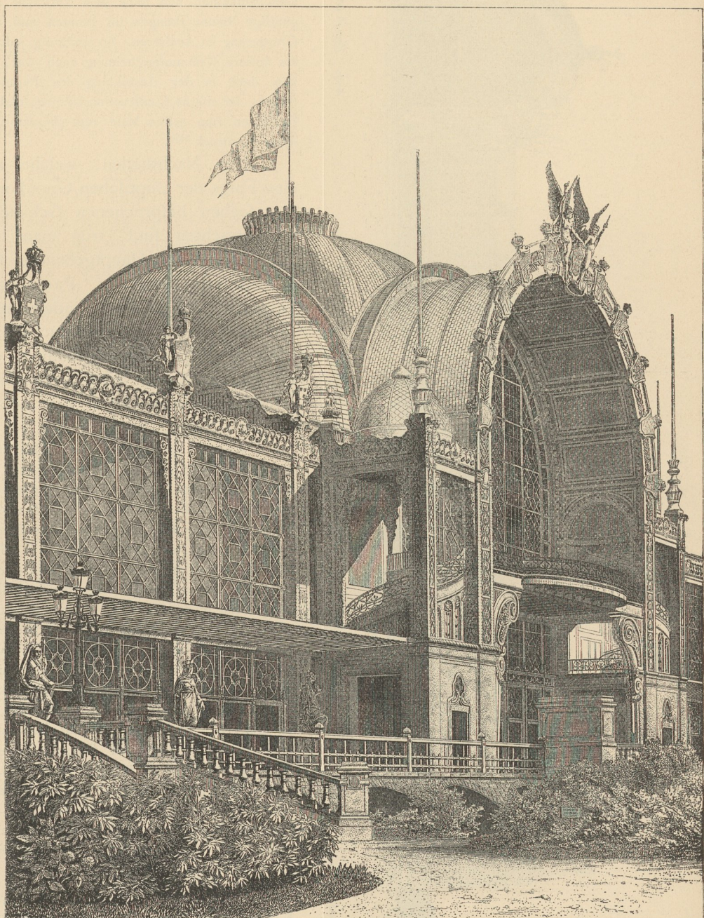
Central-Pavillon der Hauptfäçade vom Hauptgebäude der Weltausstellung zu Paris 1878 532 ).
