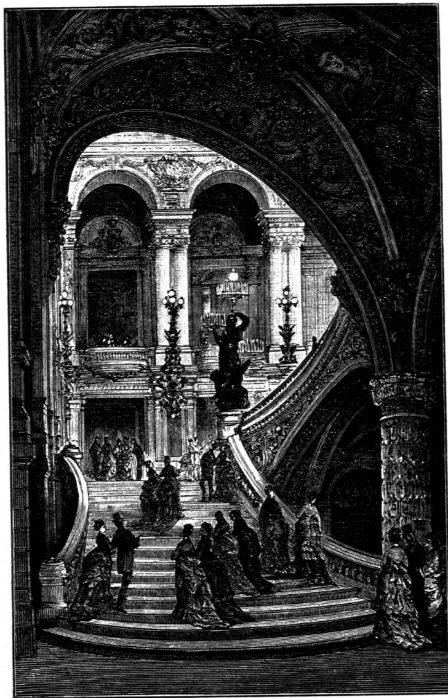
Treppe vom kreisförmigen Vestibül zum Haupttreppenhaus in der Grofsen Oper zu Paris 45) .
