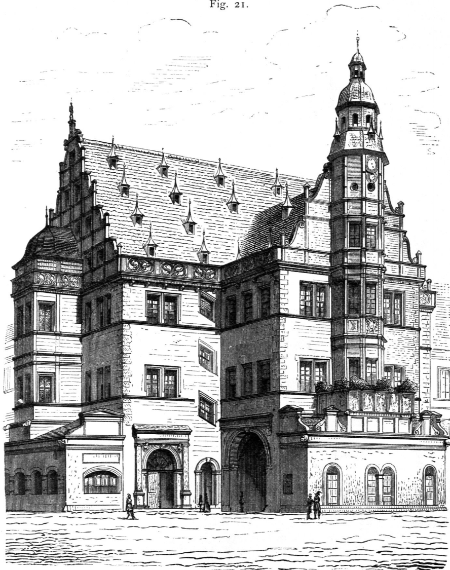
Rathhaus zu Schweinfurt 56 ).
