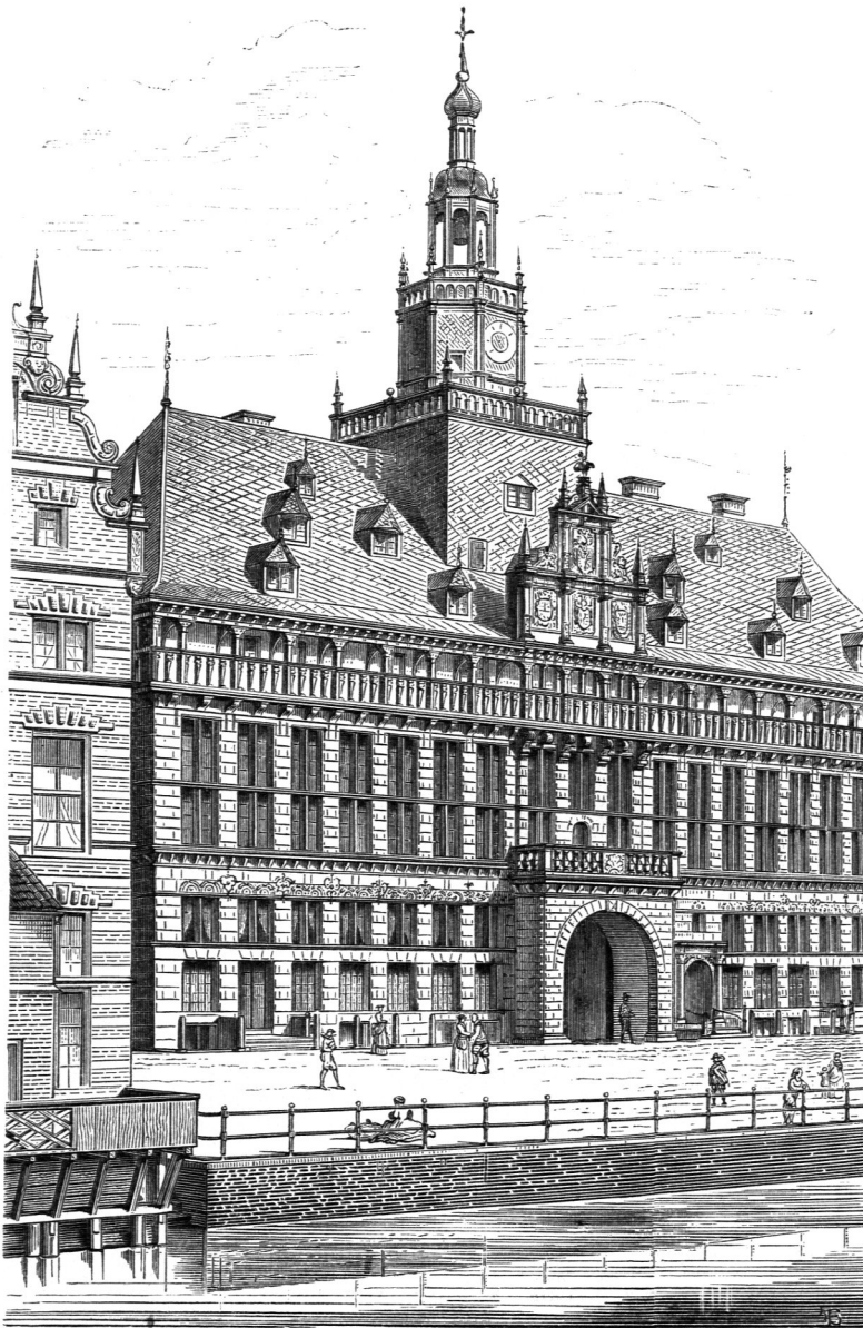
Rathhaus zu Emden 60) .
