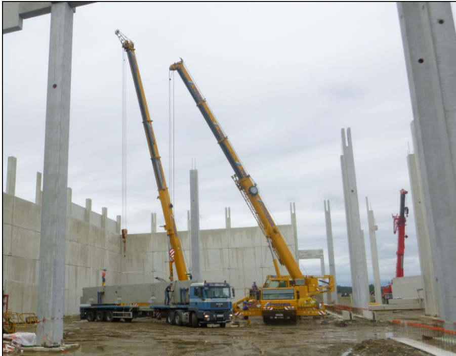
Abbildung 12 Vertikale Montage mit Autokran 135
