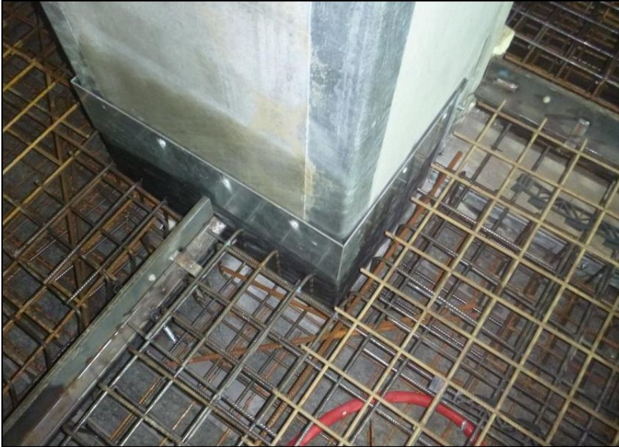
Abbildung 30 Fugenausbildung bei aufgehenden Bauteilen 224
