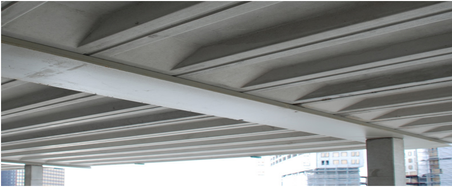
Abbildung 17 Tragsystem CD20 Bouwsystemen 153
