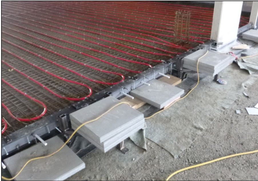
Abbildung 29 Fugenprofil 220
