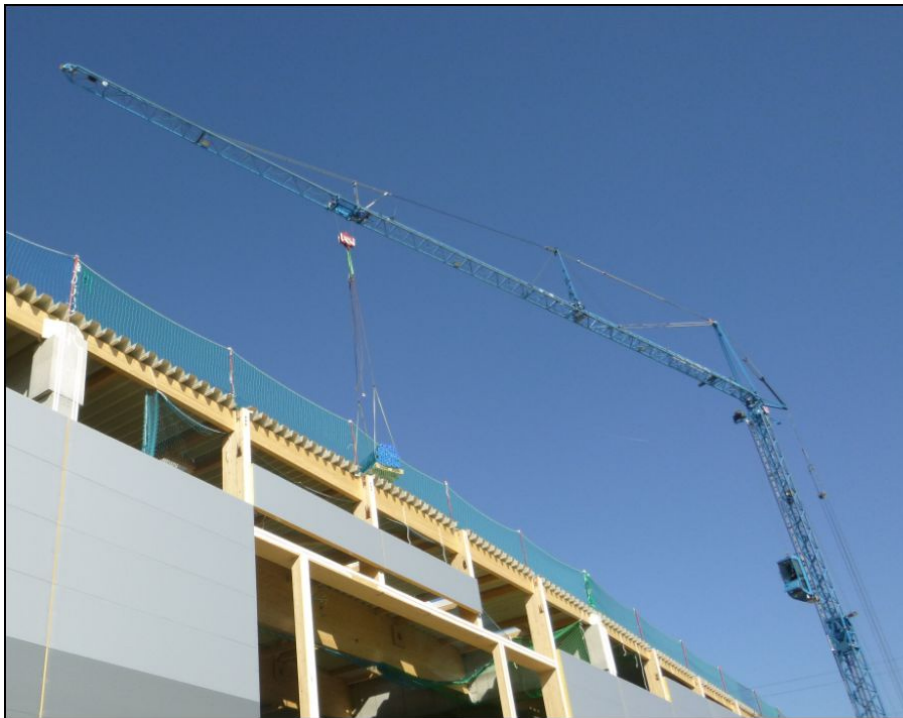
Abbildung 11 Turmdrehkran bei horizontaler Montage 134
