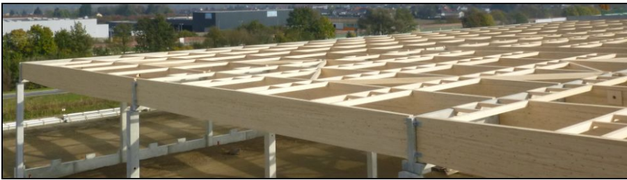
Abbildung 20 Tragwerk aus Brettschichtholz 168
