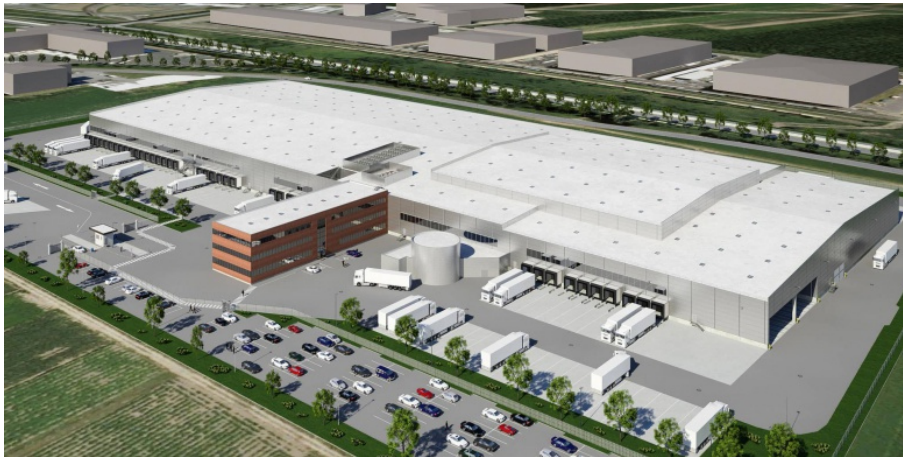
Abbildung 6 Logistikhalle mit anschließendem Bürogebäude 111
