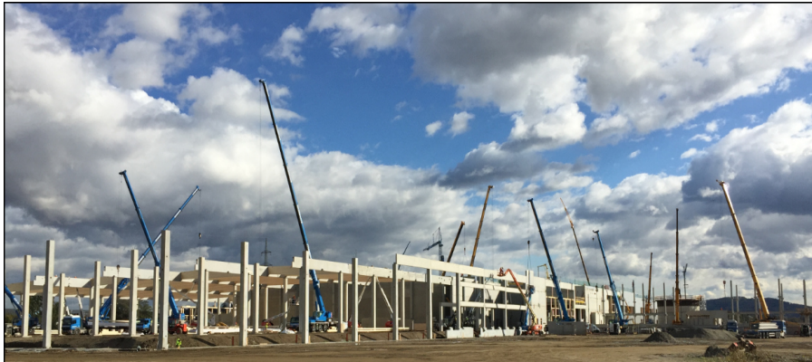
Abbildung 9 Montage Fertigteile mit Autokränen 122
