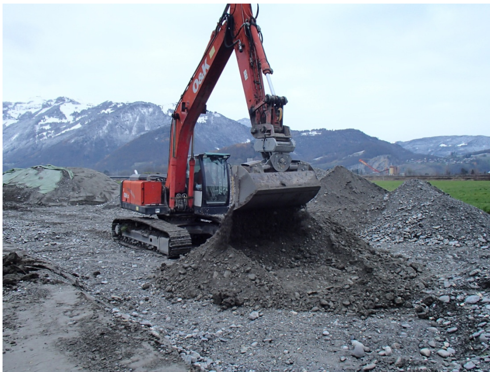
Abbildung 51 Durchmischung der EMD auf der Manipulationsfläche
