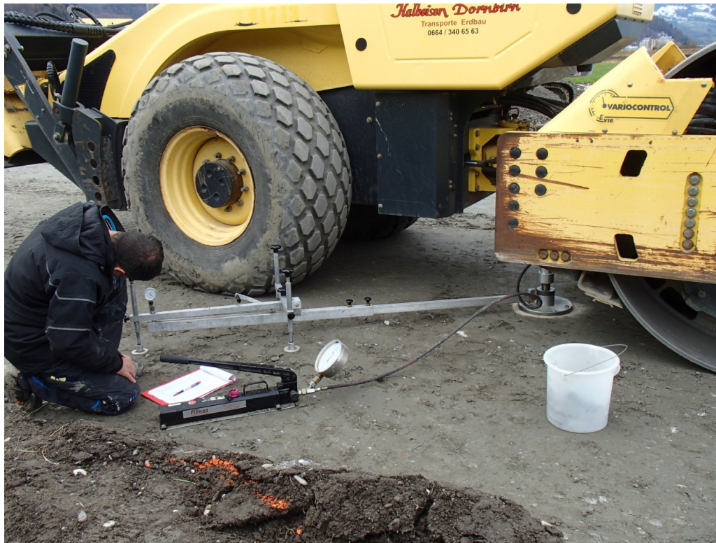
Abbildung 61 Statischer Lastplattenversuch Insituversuch Damm
