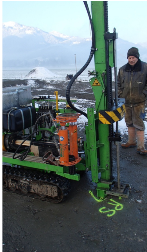
Abbildung 63 Durchführung der Rammsondierung
