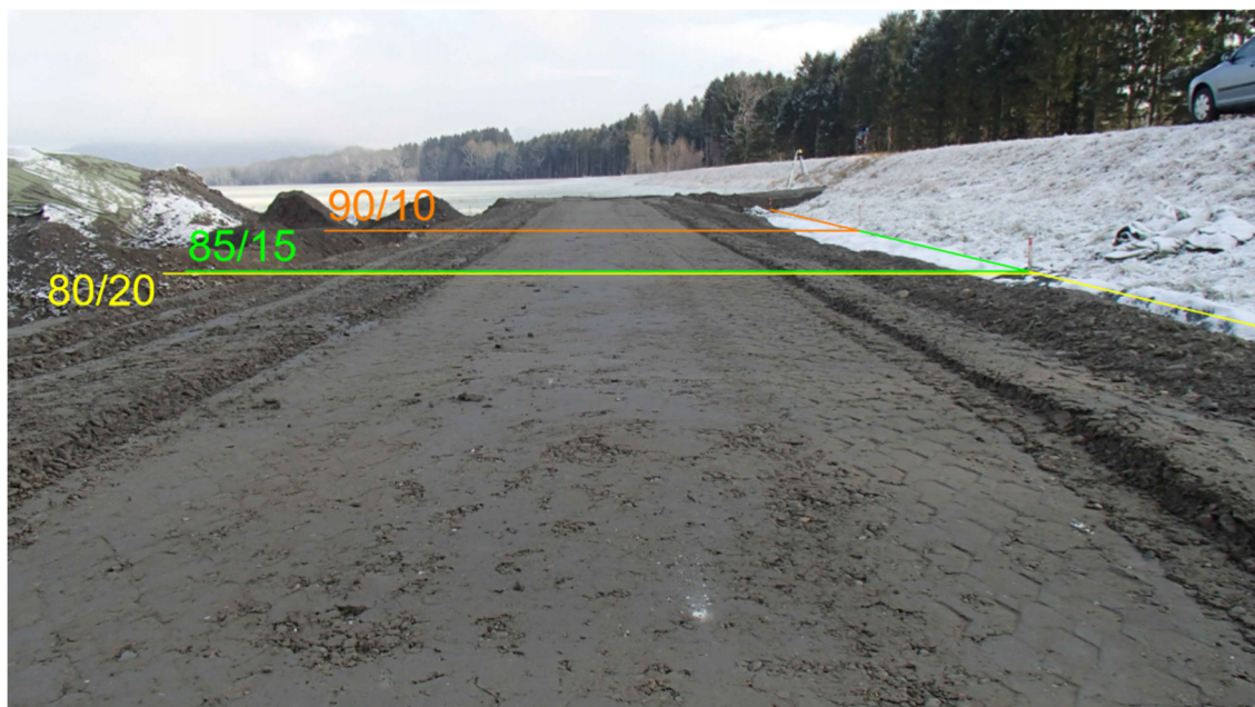
Abbildung 53 Überblick verdichtete Lage mit gekennzeichneten EMD-Materialien
