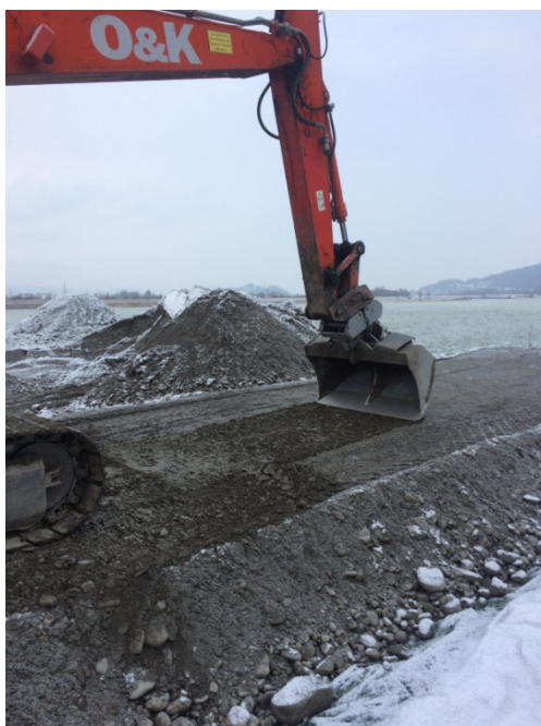
Abbildung 55 Aufrauen der glatten Oberfläche
