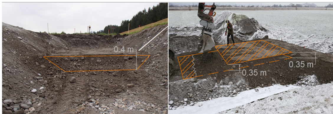
Abbildung 52 lagenweise Schüttung des Dammes
