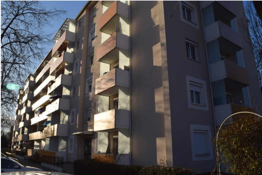
Abbildung 2: Ostansicht des Gebäudes
