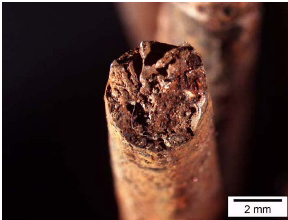
Abb. 21 Aufgetretene Spannungsrisskorrosion an einem Draht (Maurer, et al., 2010)
