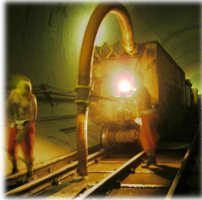
Abbildung 21: Schlammabsaugung (KUC)
