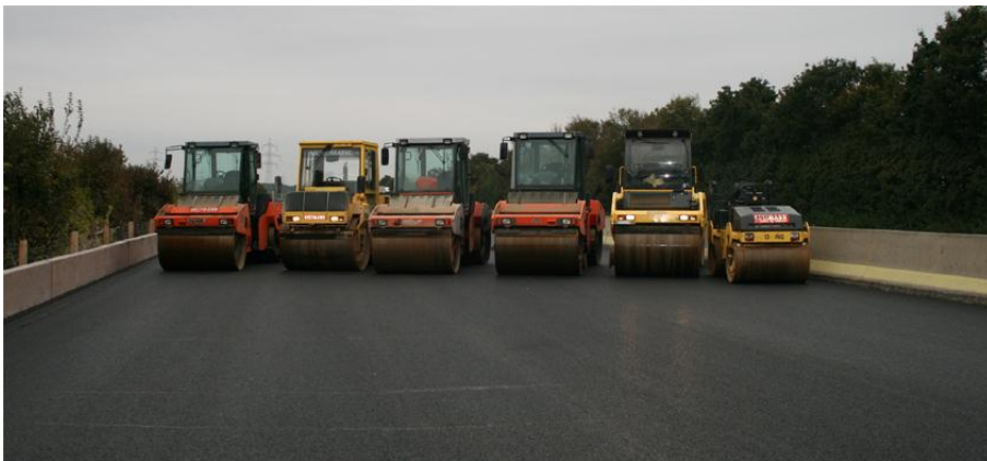
Bild 5.10: Walzen zur Herstellung der Deckschicht
