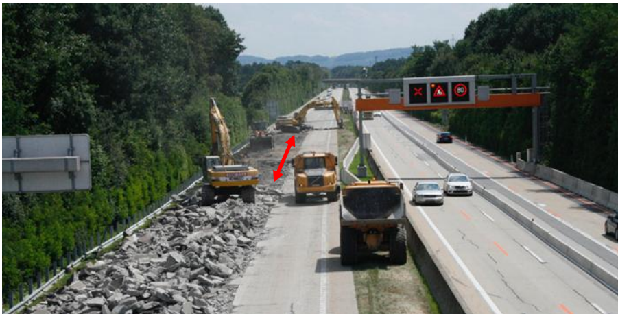
Bild 3.9: Abstand zwischen Lade- und Reißbagger
