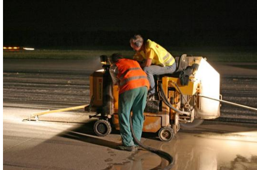
Bild 3.18: Betonplatten schneiden 36
