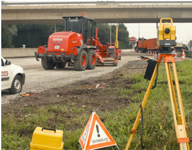
Bild 4.13: Feinplanieren des Zusatzmaterials mit 3D-gesteuerter Grader
