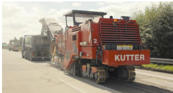
Bild 3.20: Fräsen einer Betonfahrbahn 39
