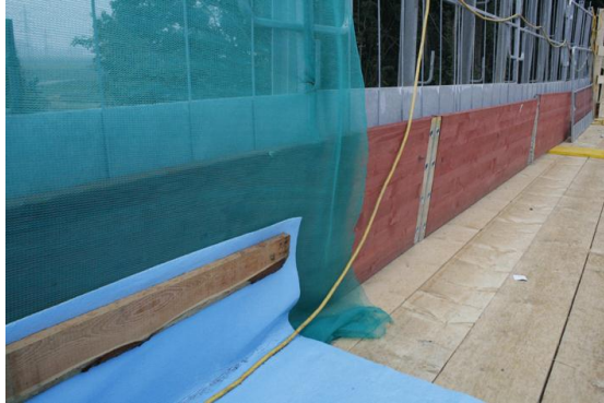
Bild 6.16: Ausbildung des Schutzgerüsts mit dichtem Boden
