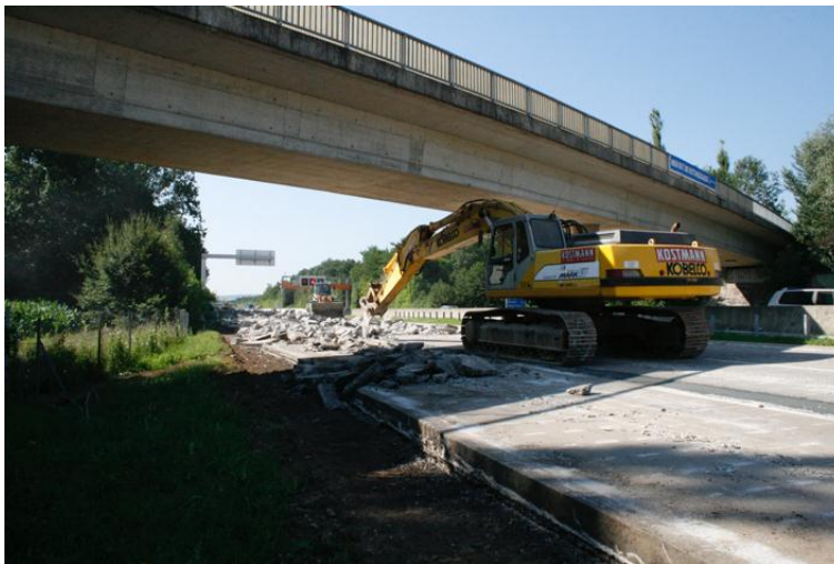
Bild 3.11: Reißen bei eingeschränkter Höhe
