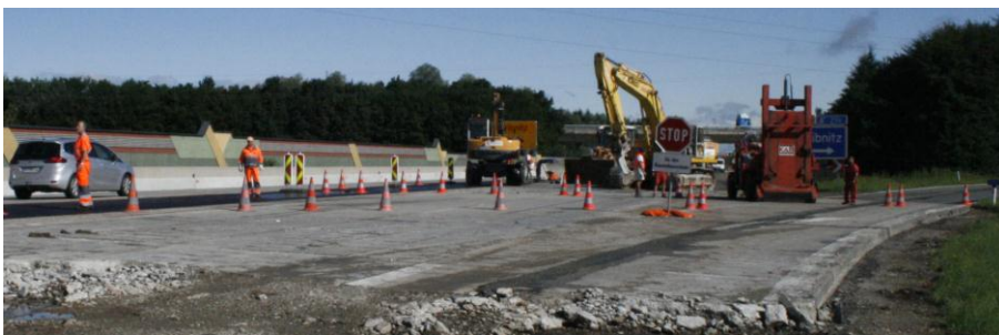
Bild 3.12: Abbruch der Autobahnabfahrt Leibnitz
