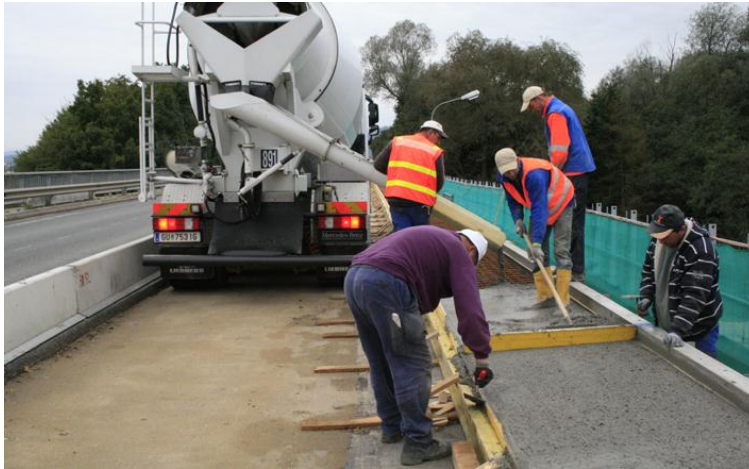
Bild 6.17: Betonieren des Randbalkens
