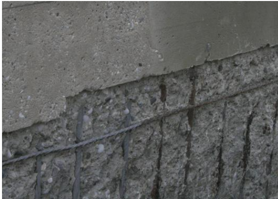
Bild 6.6: Reinigen der Bewehrung mit festen Strahlmittel
