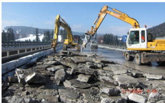
Bild 3.19: Abtrag der Betonfahrbahn auf einer Brücke 37
