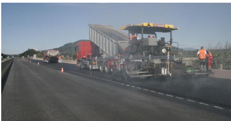
Bild 5.9: Beschickung des Großfertigers
