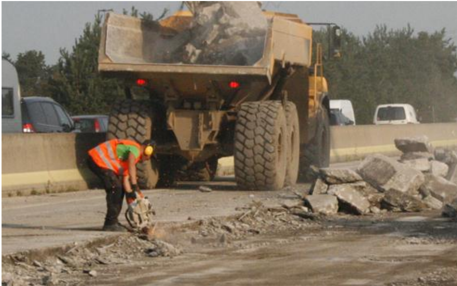
Bild 3.10: Schneiden der herausragenden Anker
