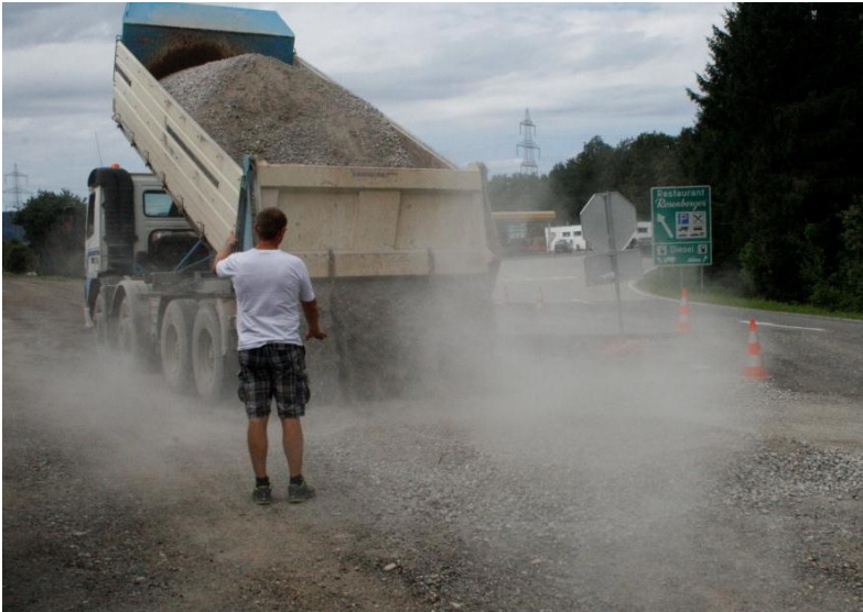
Bild 4.12: Einweisen des LKWs beim Vorlagern des Zusatzmaterials
