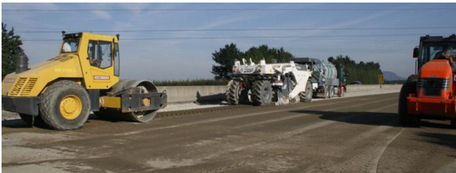
Bild 4.17: STZ-Fräse mit Erdbauwalzenzug
