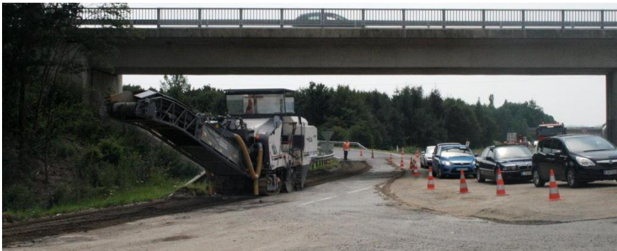
Bild 4.10: Fräsarbeiten im Bereich der Ausfahrt
