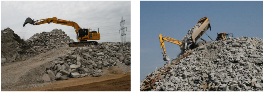
Bild 3.13: Rampenherstellung und Entladung an Abwurfkante
