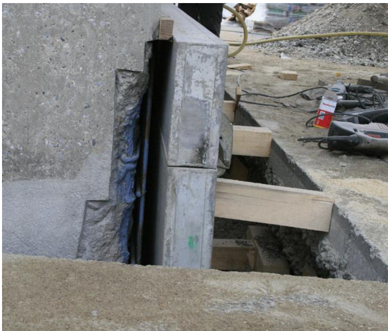
Bild 6.7: Vorsatzschale für fließfähigen Instandsetzungsmörtel
