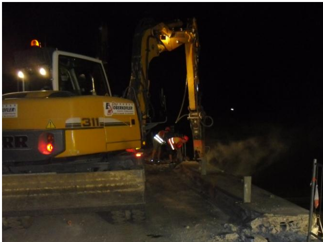
Bild 6.14: Abbrechen Randbalken im Nachteinsatz 111
