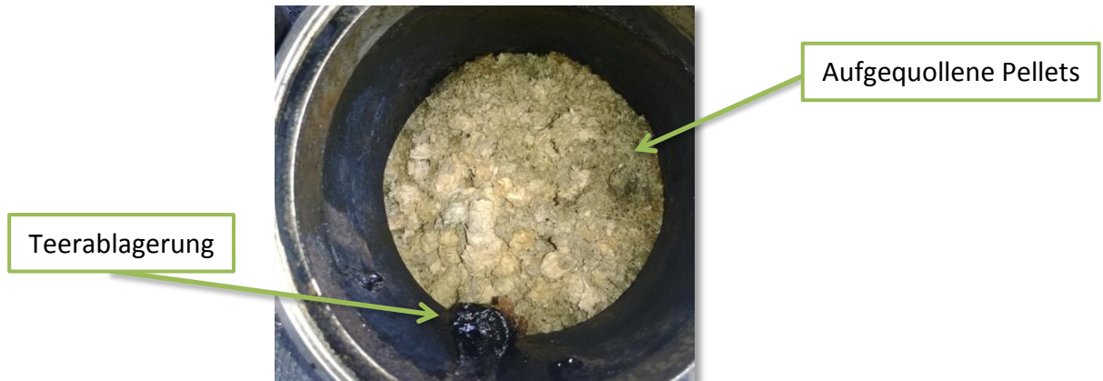
Abbildung 5-9: Blick in den Reaktorraum - Aufgequollene Holzpellets
