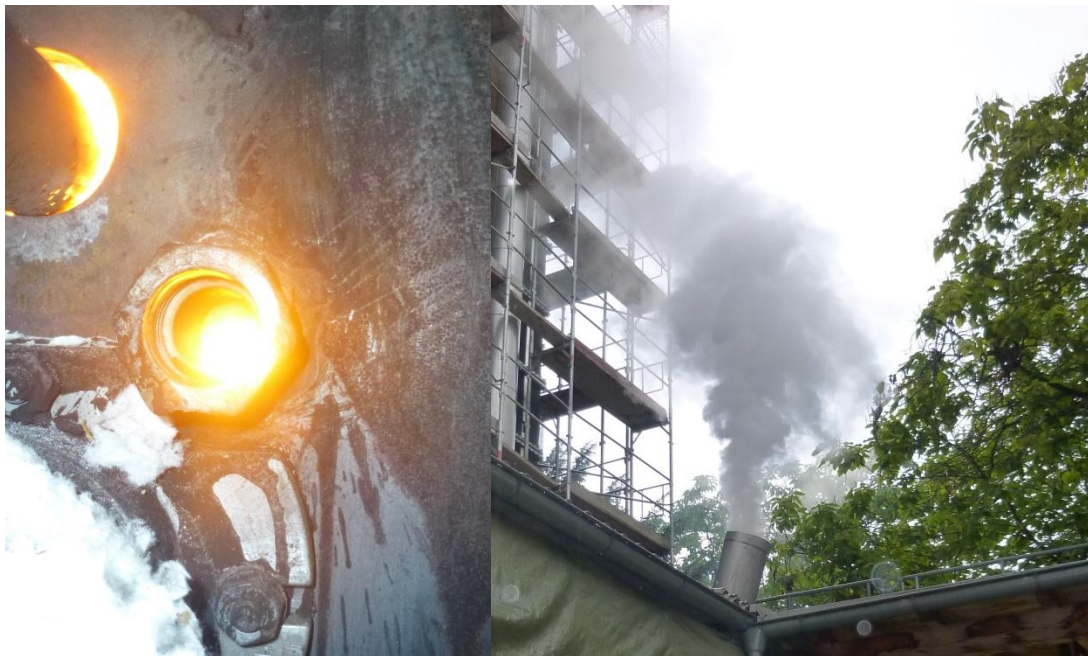
Abbildung 4-31: links Slurry- und Erdgasflamme; rechts Rauchgas bei Slurry- und Erdgasverbrennung
