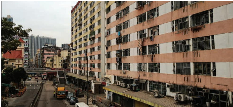
Abb. 190: nicht renovierte Gebäude
