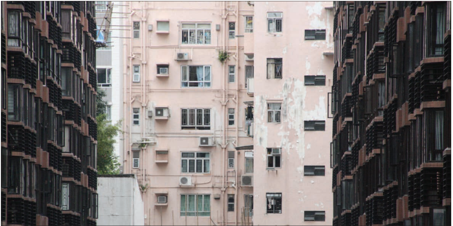
Abb. 195: Fassadendesign mit in den Gebäude integrierten Klimageräten
