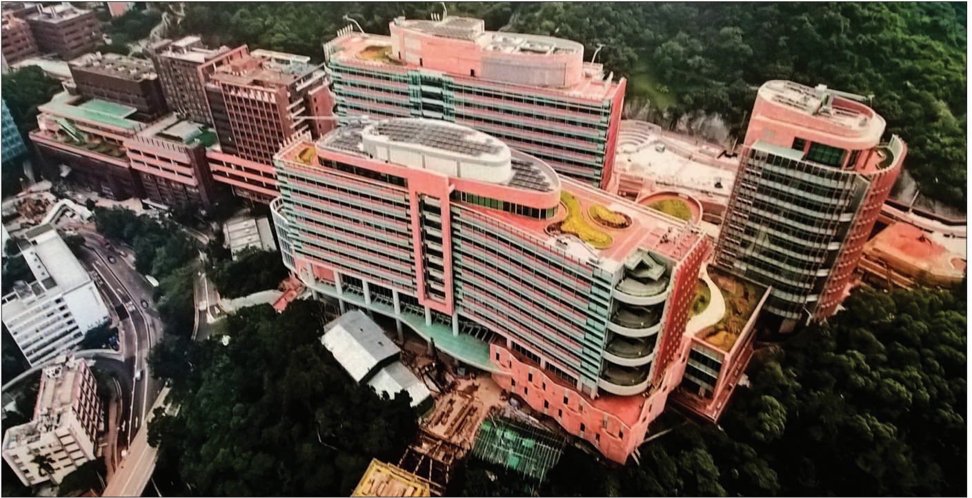
Abb. 486: Gesamtansicht Hongkong University
