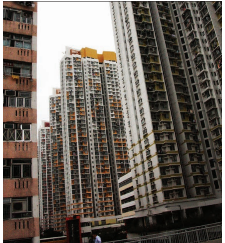
Abb. 184: renovierte Wohnblöcke mit Farbakzenten
