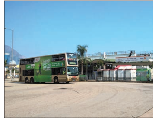
Abb. 366: Busbahnhof und Fährstation (1.1)
