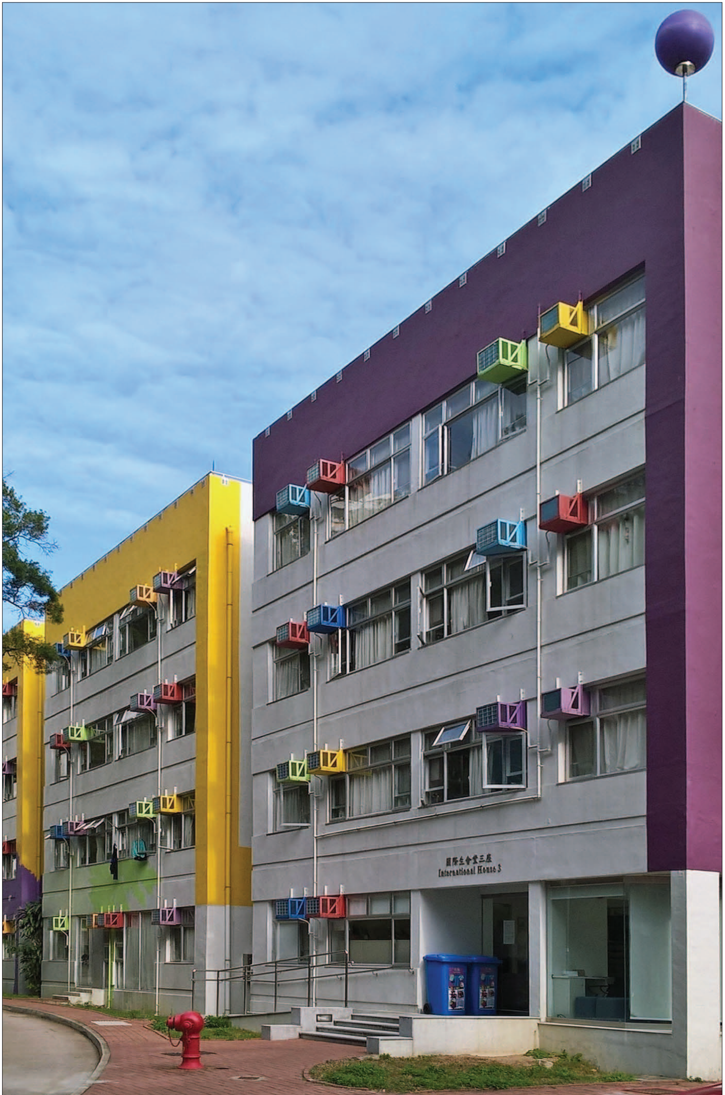
Abb. 268: Haupteingang des besichtigten Wohntraktes
