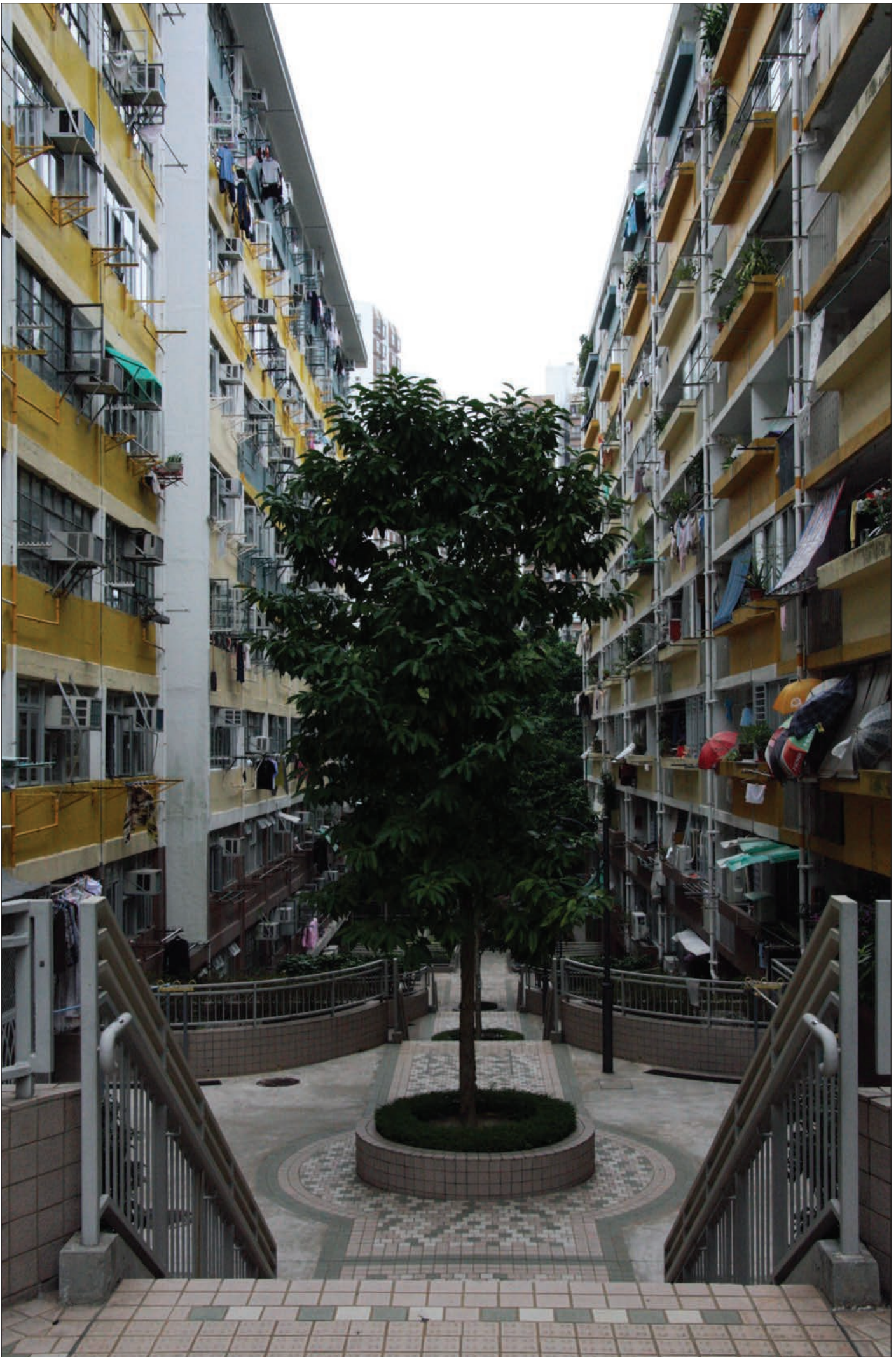
Abb. 151: Begrünung zwischen den Wohnblöcken
