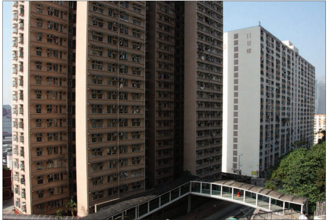
Abb. 180: an der Hauptstraße orientierte Gebäuderückseite
