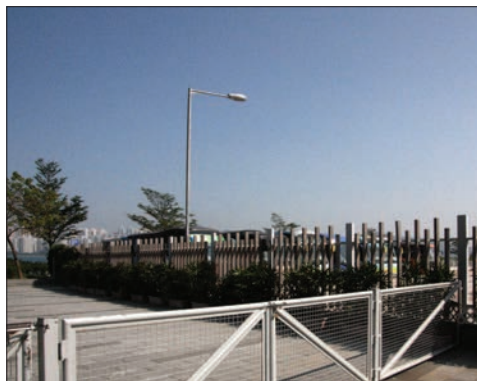
Abb. 373: Zugang zur Promenade (2.3)
