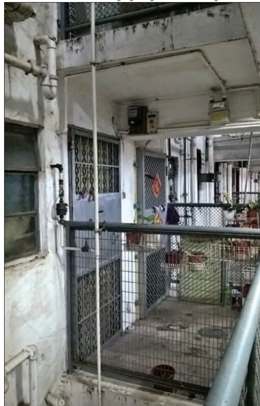
Abb. 153: Eingangssituation der Wohnungen
