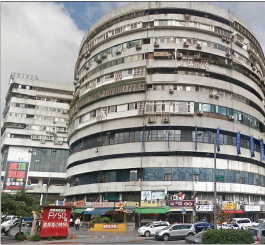
Abb. 320: Ansicht des Gebäudes von der Rückseite
