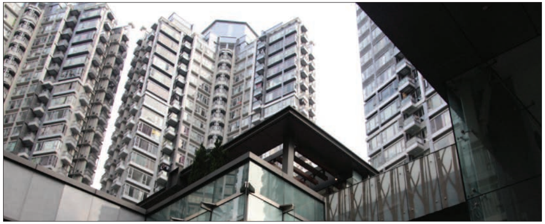
Abb. 96: Gebäudeansicht aus dem Innenhof
