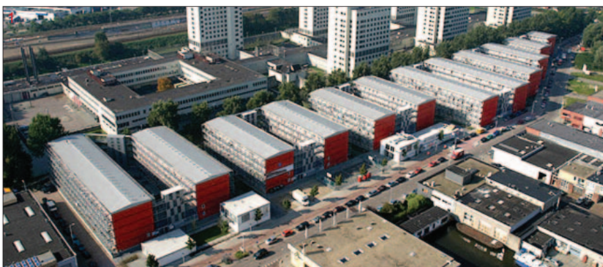
Gesamtansicht des Containerensembles
