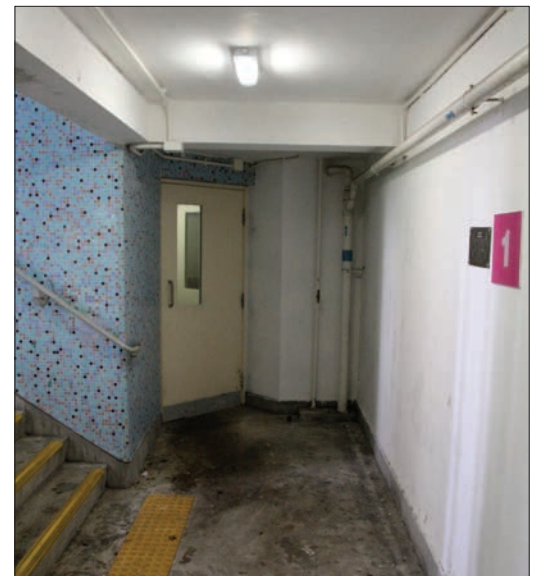
Abb. 34: Fluchttreppenhaus Oi Ping Gebäude
