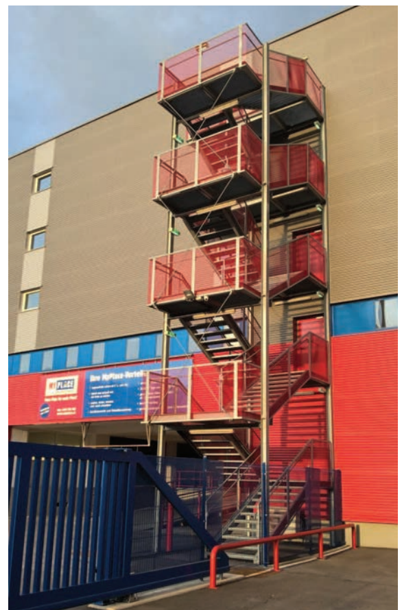
Abb. 450: Außentreppe des Gebäudes MyPlace, Graz
