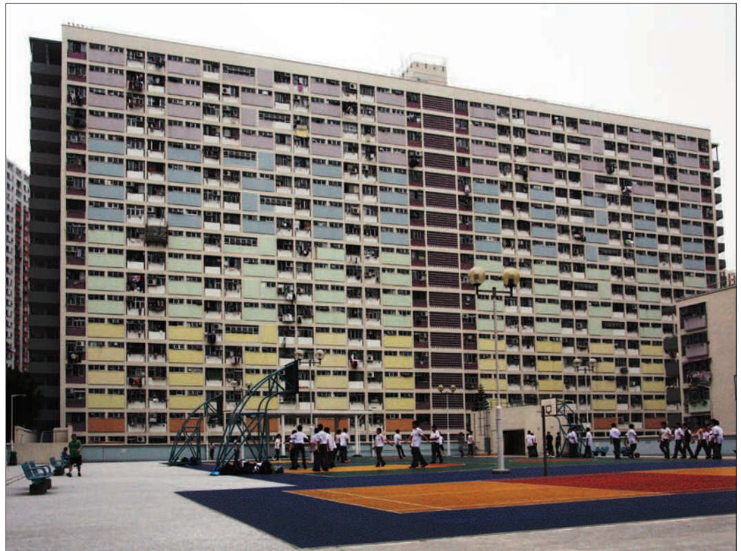
Abb. 163: Sportplätze auf dem Dach der Parkanlage
