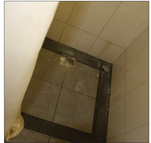
Abb. 236: Kalkablagerungen
