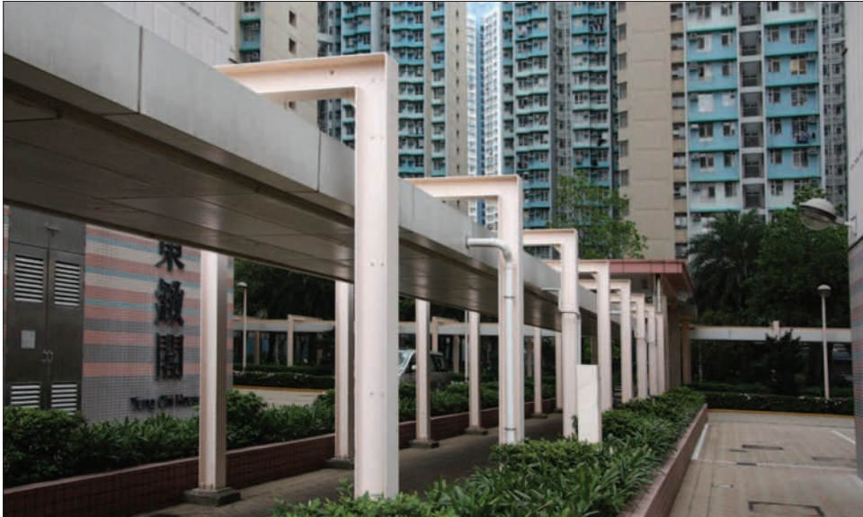
Abb. 31: Erschließungsgang im Innenhof des Oi Ping Estate
