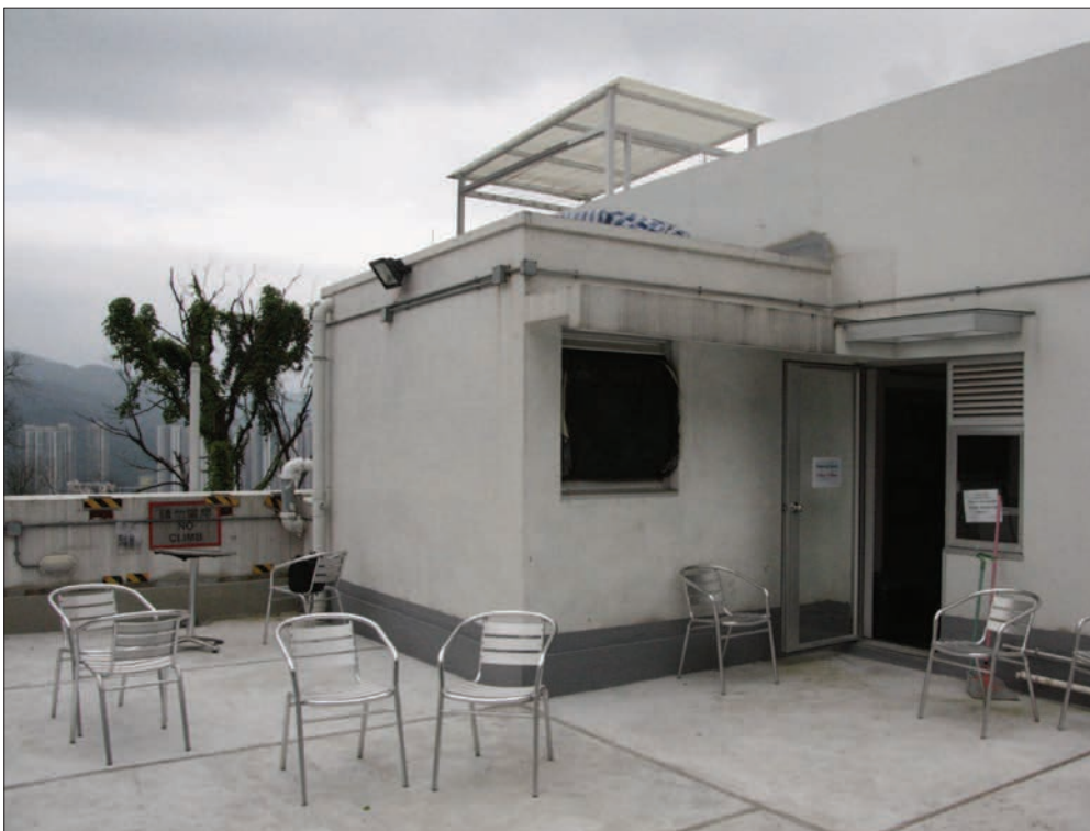
Abb. 284: Eingang zur Küche
