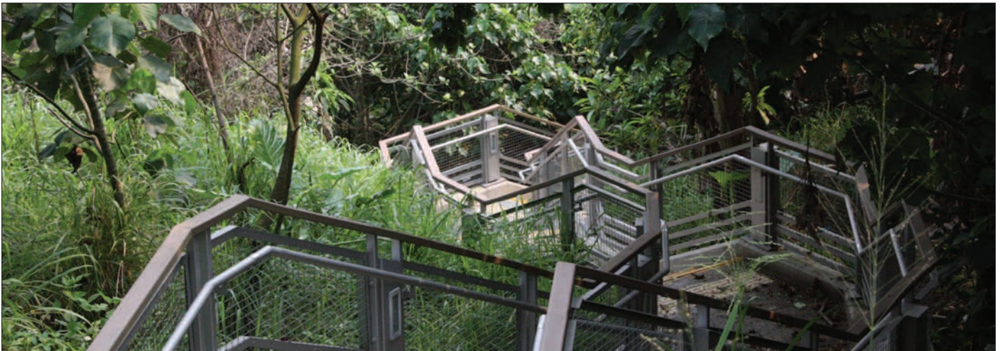
Abb. 193: Treppenabgang zum Stanley Beach
