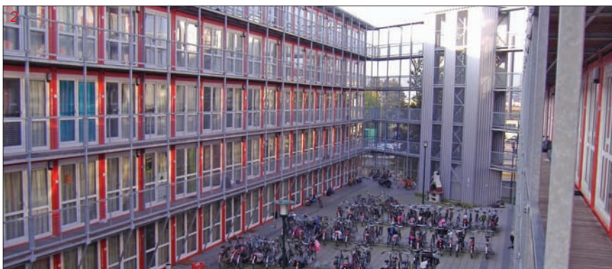
Innenhof des Containerdorfes mit umlaufendem Erschließungsgang
