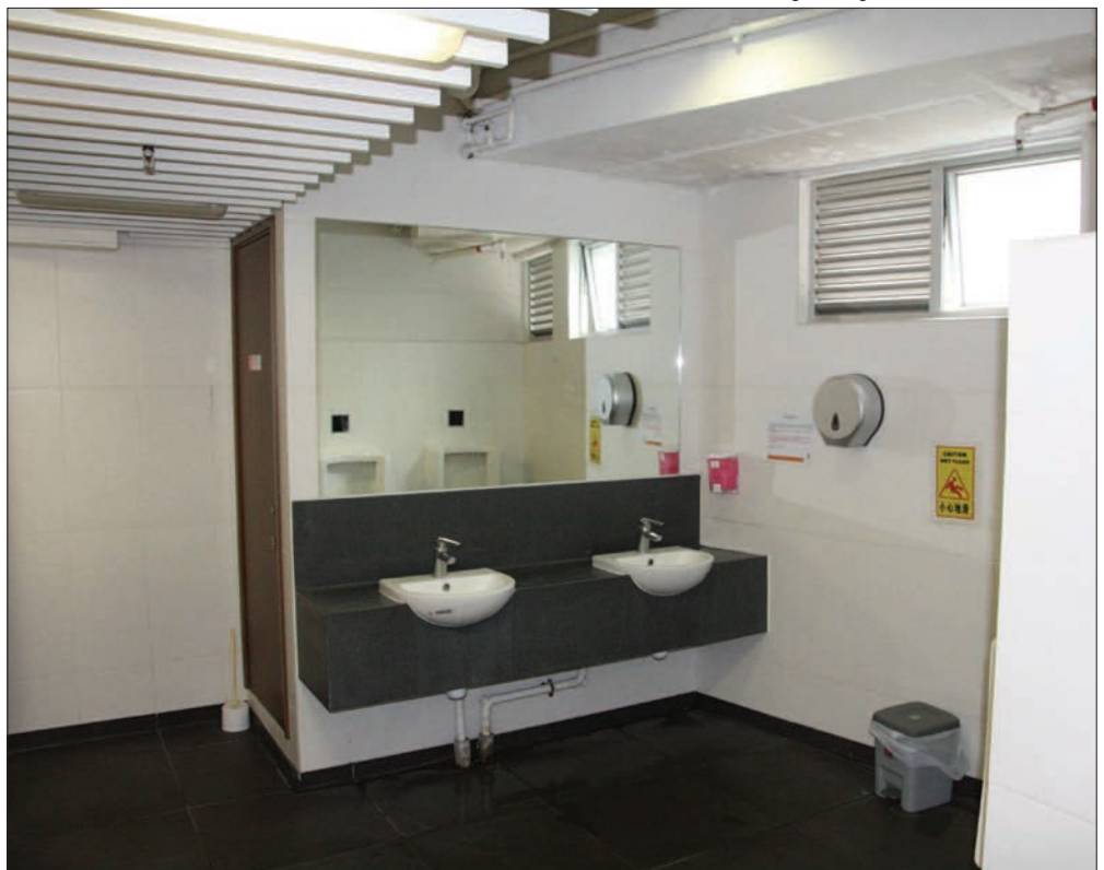
Abb. 238: Schimmelbildung an der Decke
