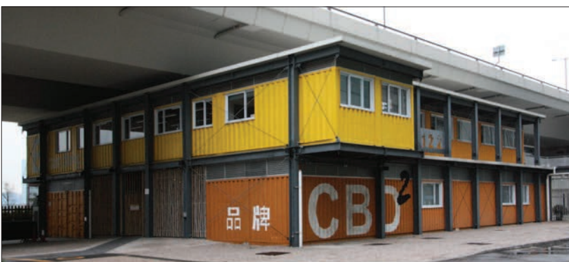
Abb. 407: Umnutzung der Erdgeschosszone unter einem Highway
