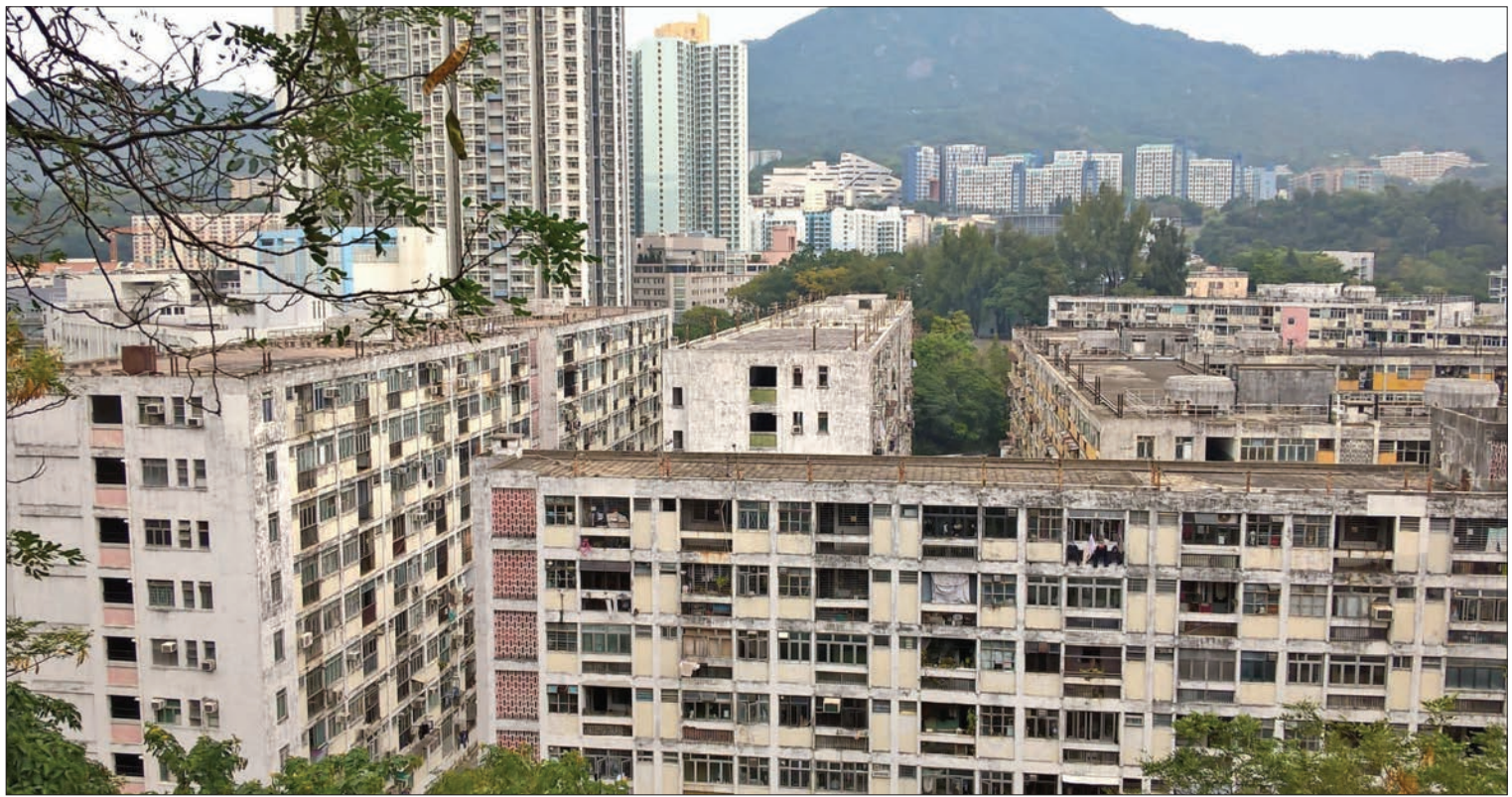
Abb. 187: Ansicht des Substandards der bis heute unrenovierten, jedoch weiterhin bewohnten, Bebauung
