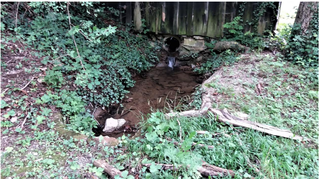
Abb. 129: Durchlass kurz vor Einmündung in Andritzbach [Q4]
