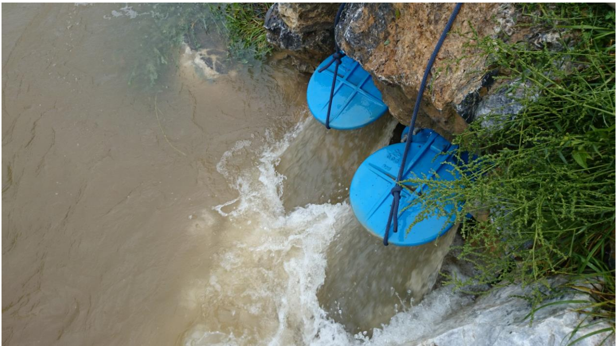
Abb. 81: Fixierte RS-Klappen beim HW im September 2014 [Q14]
