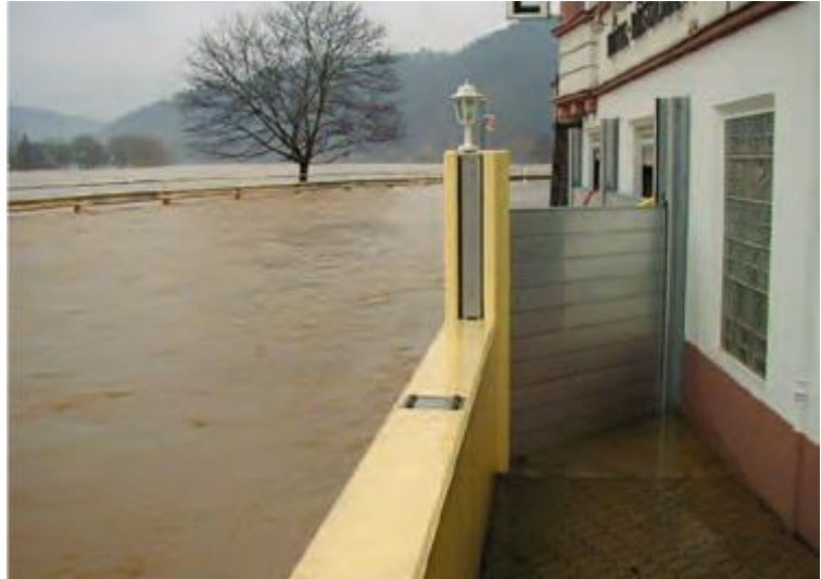
Abb. 43: HW-Schutz mit teilmobilen Elementen [3]
