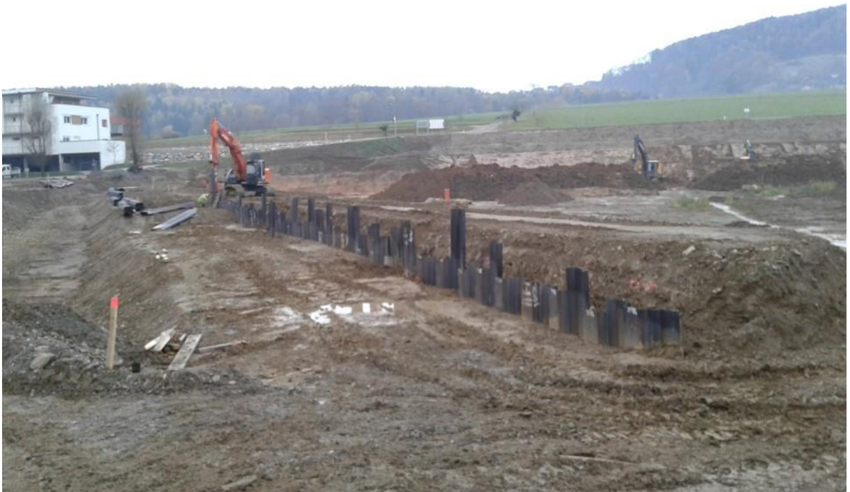
Abb. 124: RHB-Andritzbach: Setzen der Spundwände [Q9]
