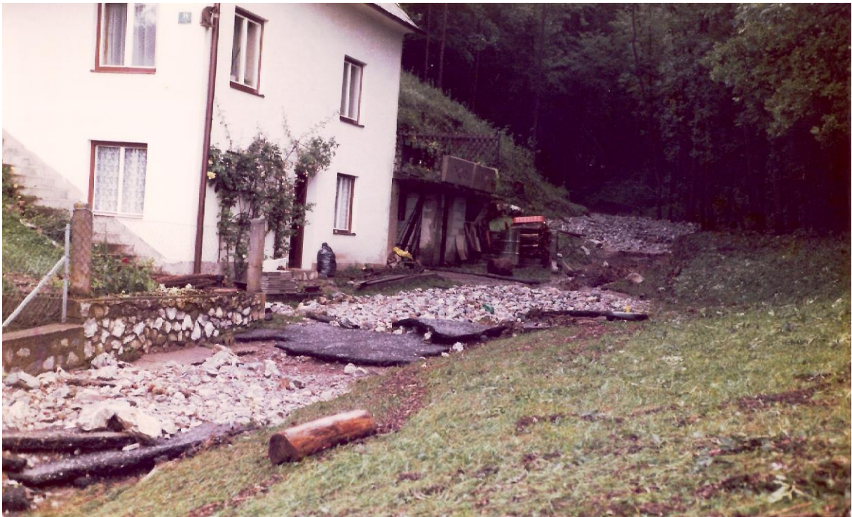
Abb. 4: Am Fuß des Falschgrabens im August 1984 [Q16]
