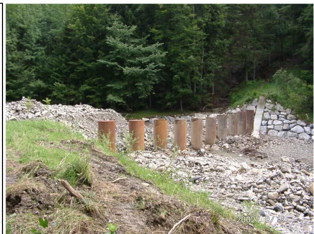
Abb. 39: Offene Aufgelöste Sperre [65]
