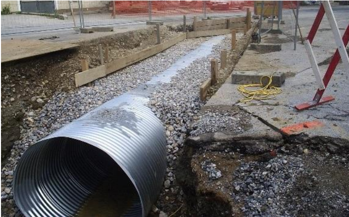
Abb. 117: Durchlass Stattegg-Neudorf in Bauphase [Q9]
