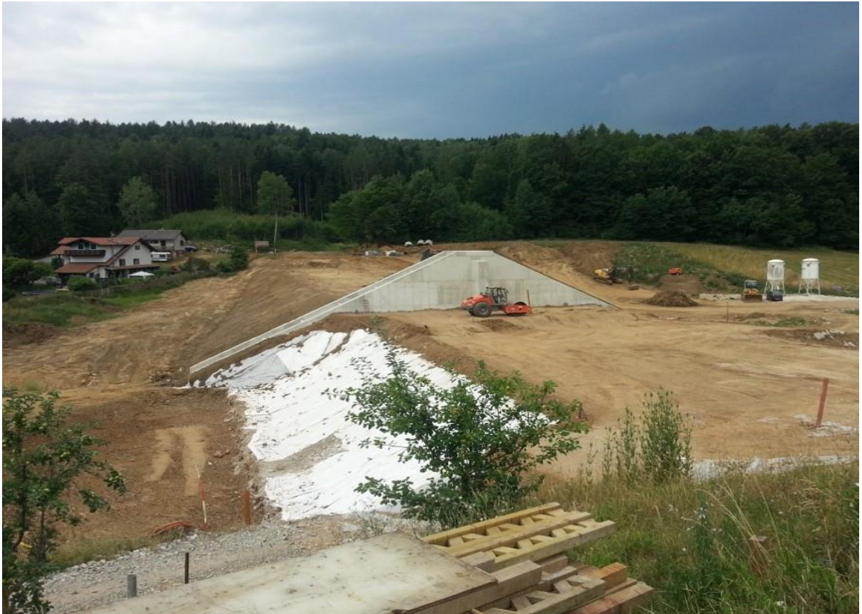
Abb. 112: RHB-Höllbach während der Bauphase (Bild 1/2) [Q9]
