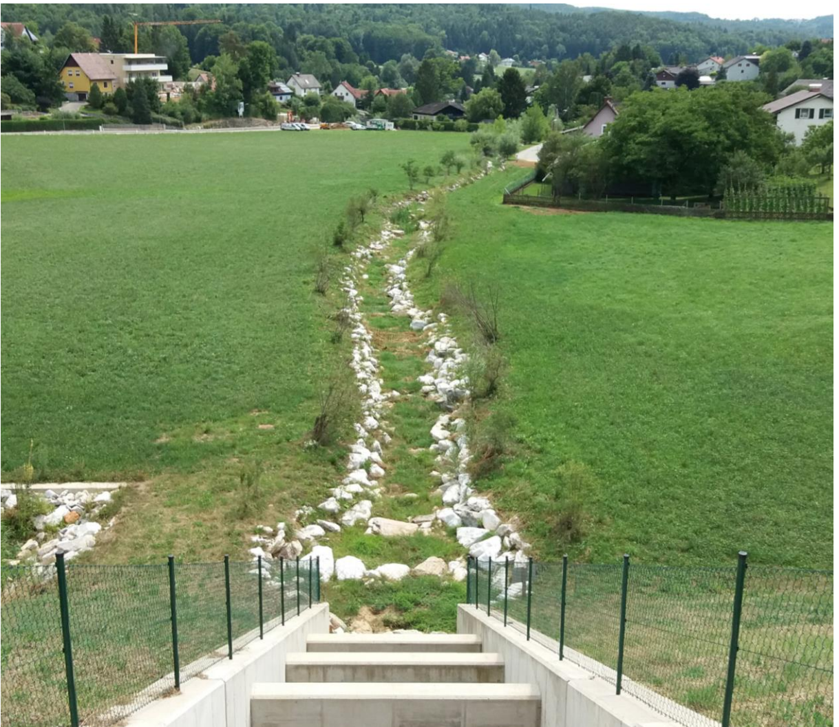
Abb. 115: Blick vom Damm auf den neuen Höllbach-Unterlauf [Q4]
