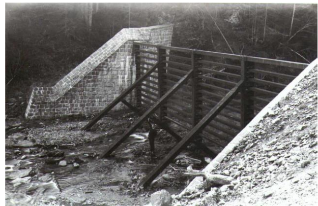
Abb. 37: Aufgelöste Balkensperre mit 3 Streben [65]
