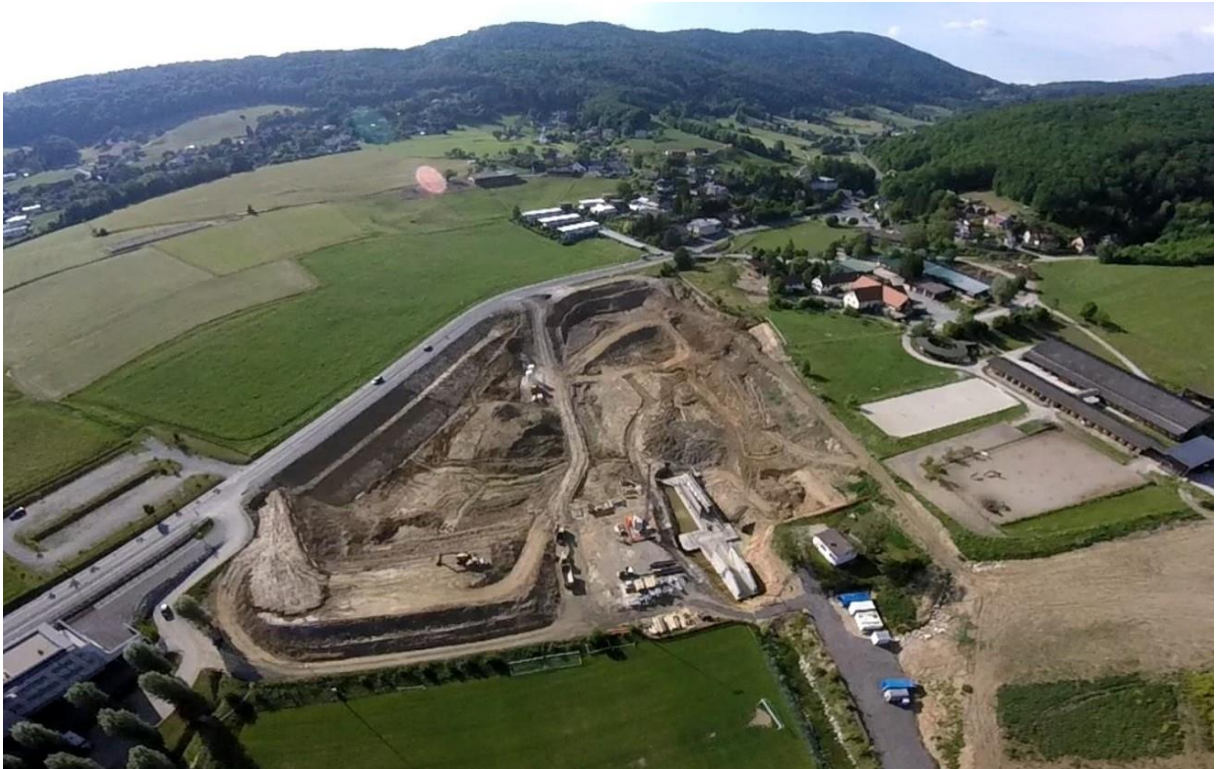
Abb. 123: Luftbild Baustelle RHB-Andritzbach [Q9]
