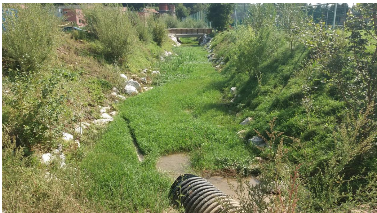
Abb. 35: Linearausbau Andritzbach neben Stelzensiedlung [Q4]
