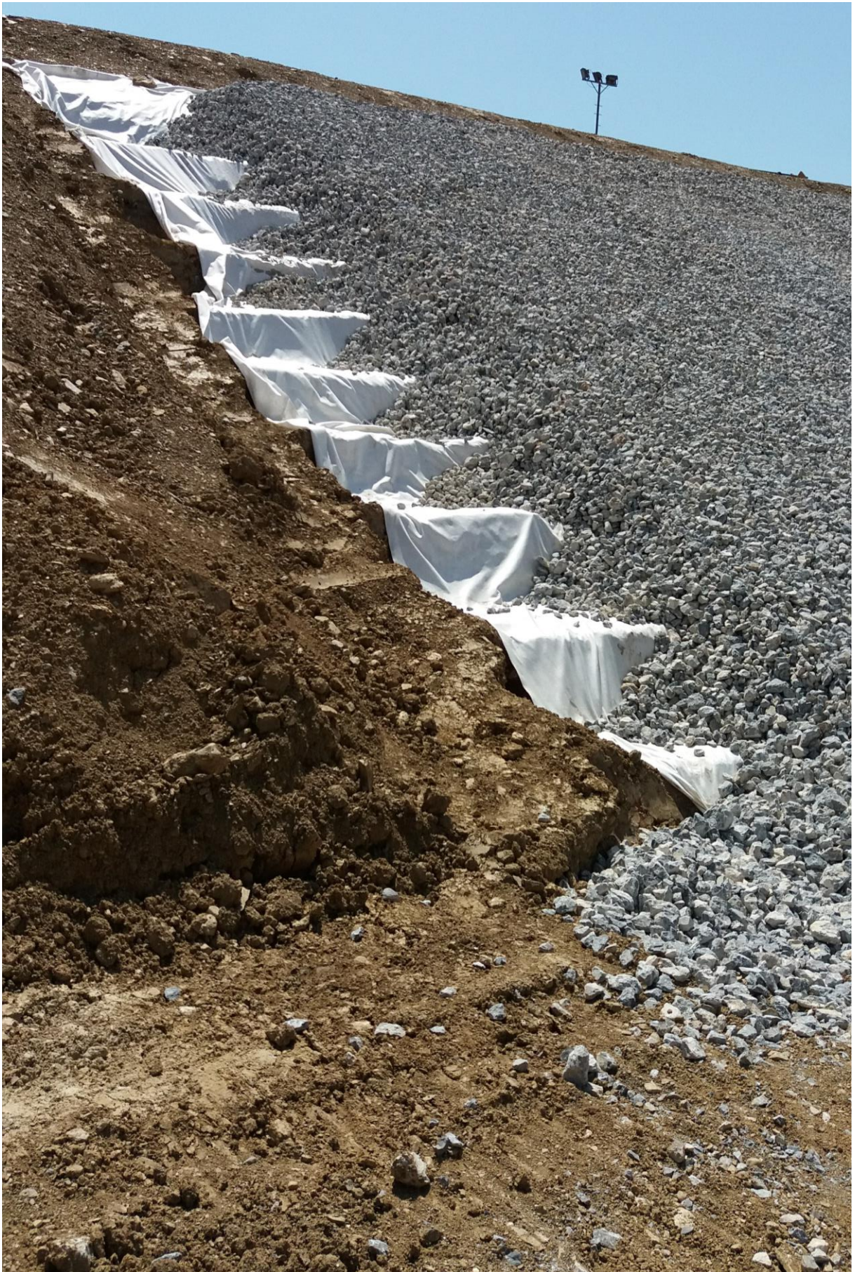
Abb. 125: RHB-Andritzbach: Aufbau Drainagekörper [Q4]
