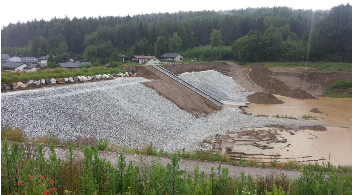
Abb. 113: RHB-Höllbach während der Bauphase (Bild 2/2) [Q9]
