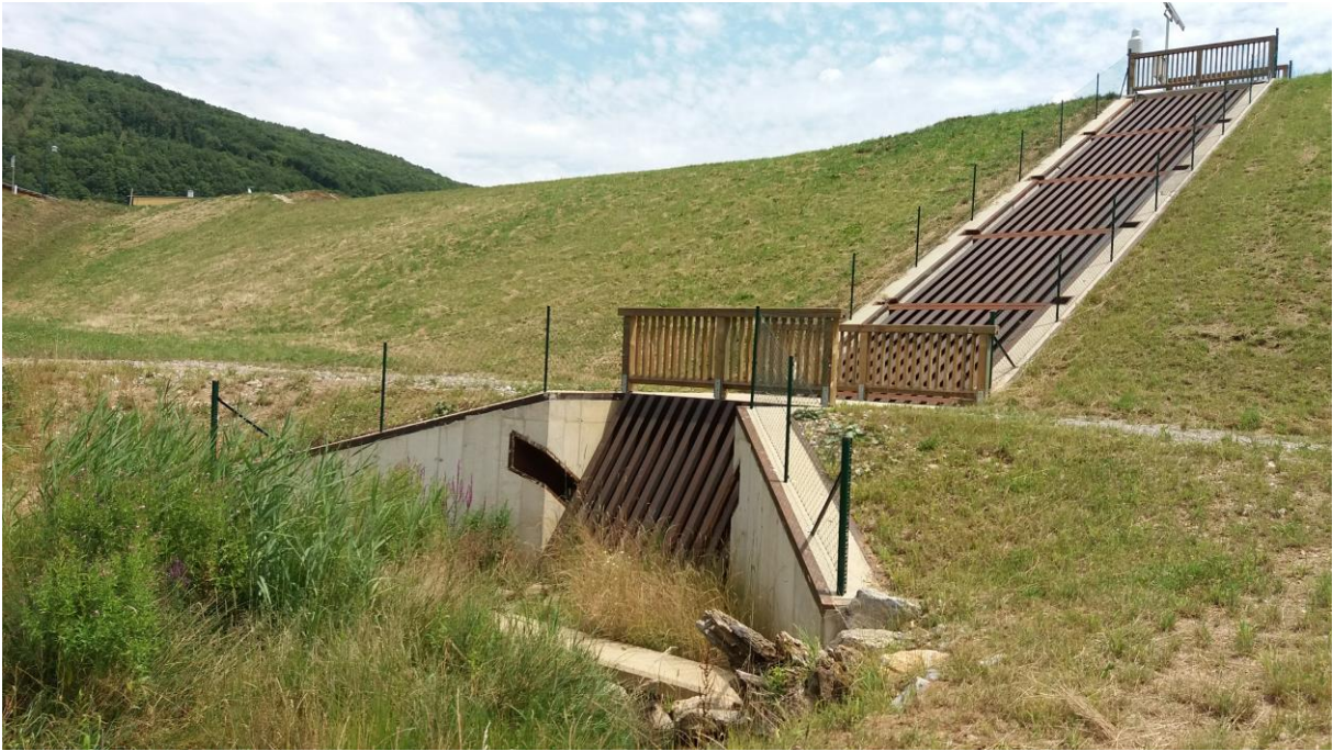
Abb. 50: Einlaufrechen bei RHB Höllbach [Q4]
