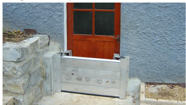
Abb. 42: HW-Schutz an Haustüren [3]
