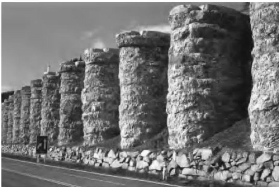
Abb. 8 Brunnenwand in der Teilansicht in einem steilen Rutschhang (Brandl, 2009)
