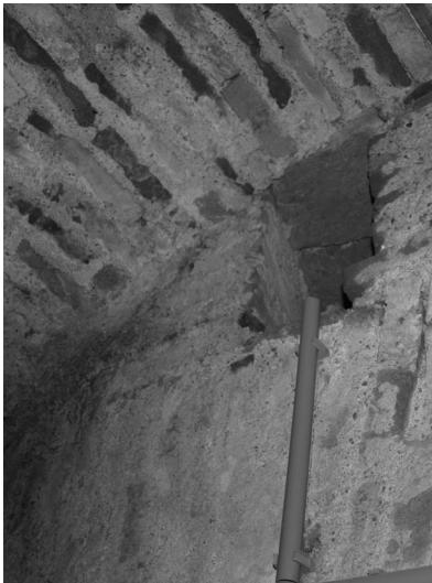
Abb.38: Öffnung über dem Zugang
