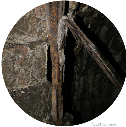
Abb.81: Korrosion
