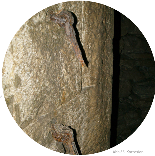
Abb.85: Korrosion
