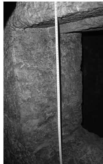
Abb.34: Maßnahmen am Fenster
