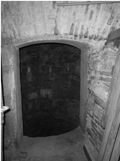
Abb.36: Zugangportal, Niveau Paulustorgasse
