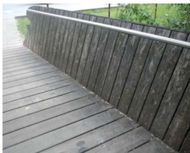
Eine kleine Brücke (Abb. 141)
