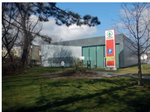
Die Brücke zum FLP wurde noch nicht gebaut (Abb. 139)
