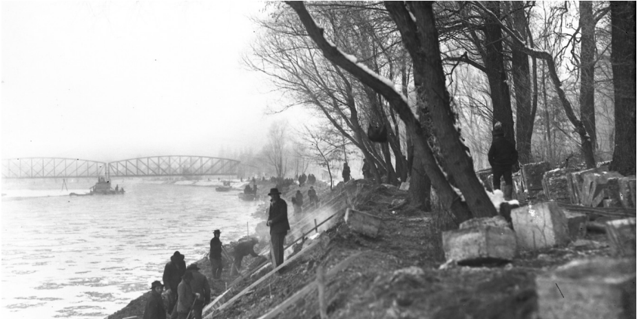
Abb. 3: Arbeiten an der Mur
