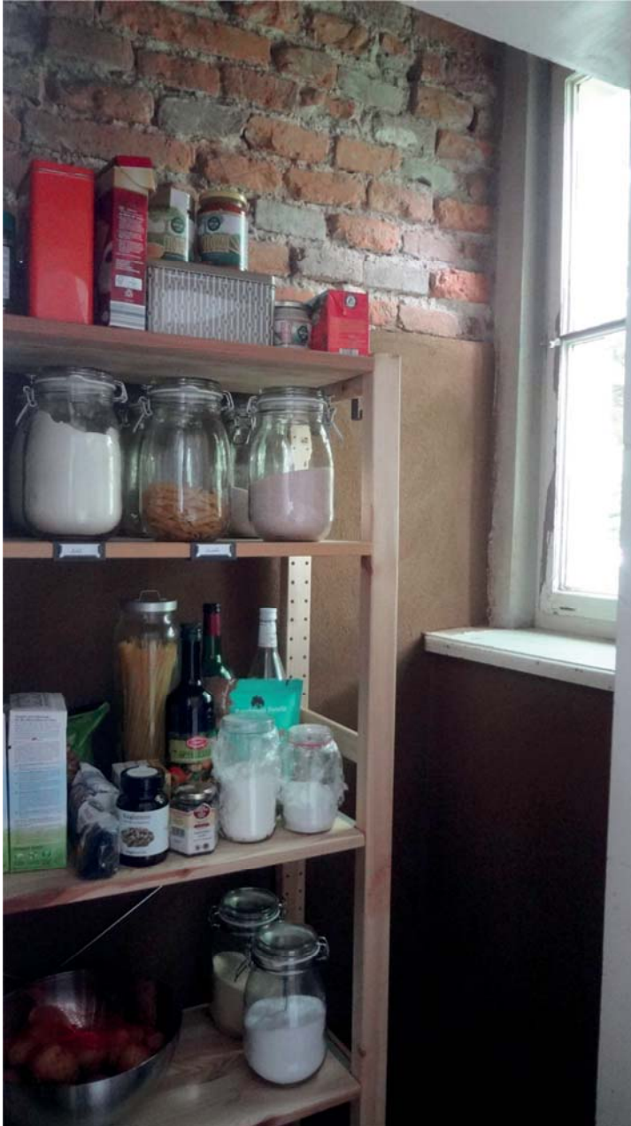
Abbildung 72 – Speisekammer im ehemaligen Raum der unteren Stiegenhaustoilette. Für ein ausgeglichenes Raumklima wurde durch die Freilegung der Ziegel im oberen Bereich die Raumbooberfläche vergrößert und durch das Verputzen des unteren Teils mit Lehm ein Feuchtigkeitsregulator geschaffen. Der für Dunkelheit sorgende Klappladen wurde für die Dauer der Fotoaufnahme geöffnet.
