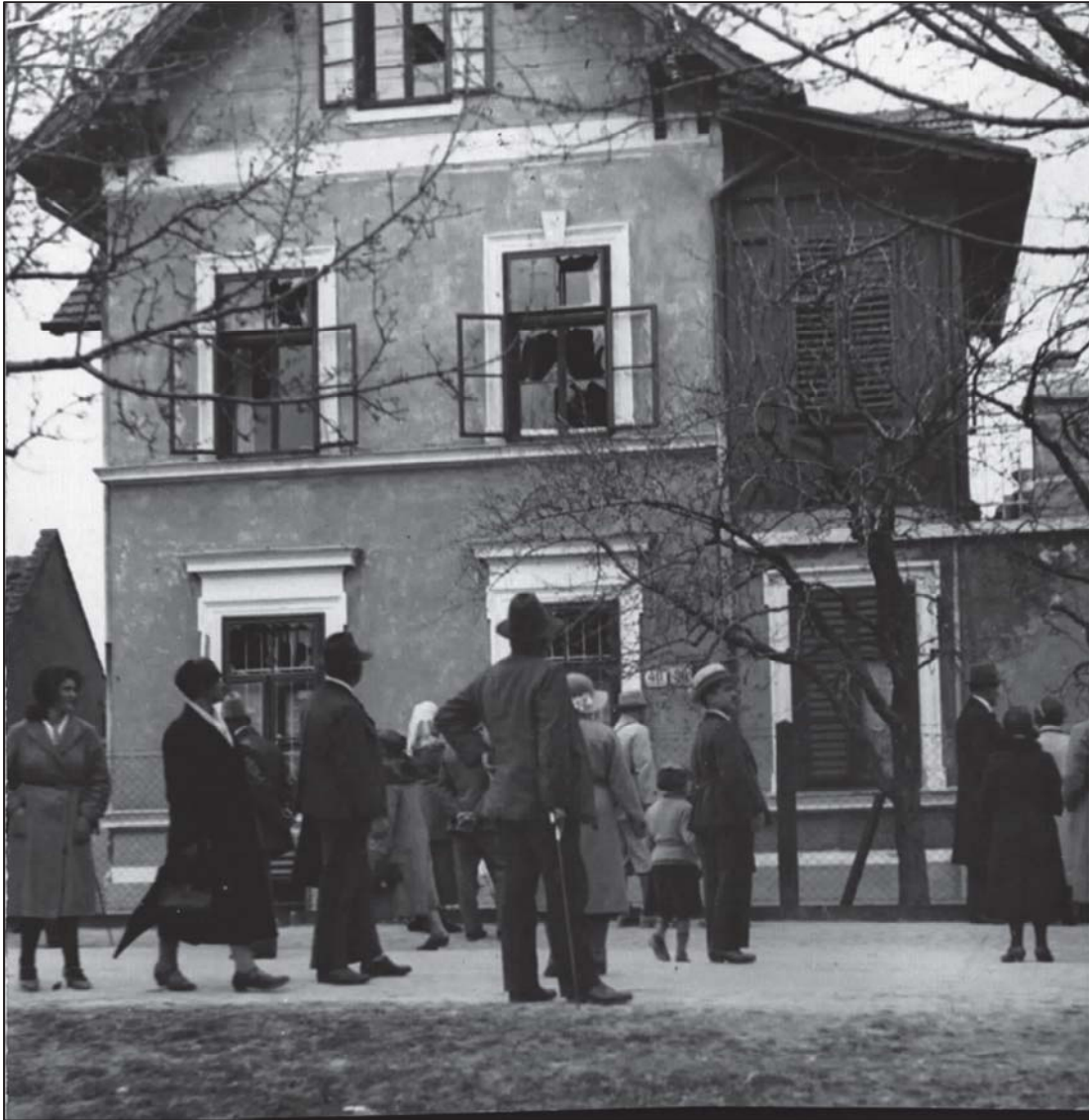
Abbildung 18 – Die straßenseitige Westfassade der Villa Hochstrasser mit zerstörten Fensterscheiben und Klappläden nach der Detonation eines Sprengkörpers (1932)
