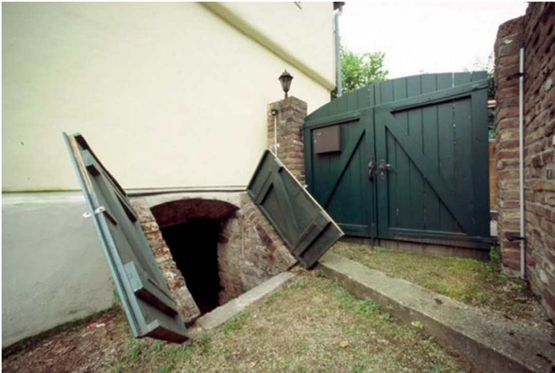
Abbildung 60 – Kellerzugang mit seitlicher Aufmauerung und Holzklappläden, Bürgermeister-Stroof-Haus, Bonn
