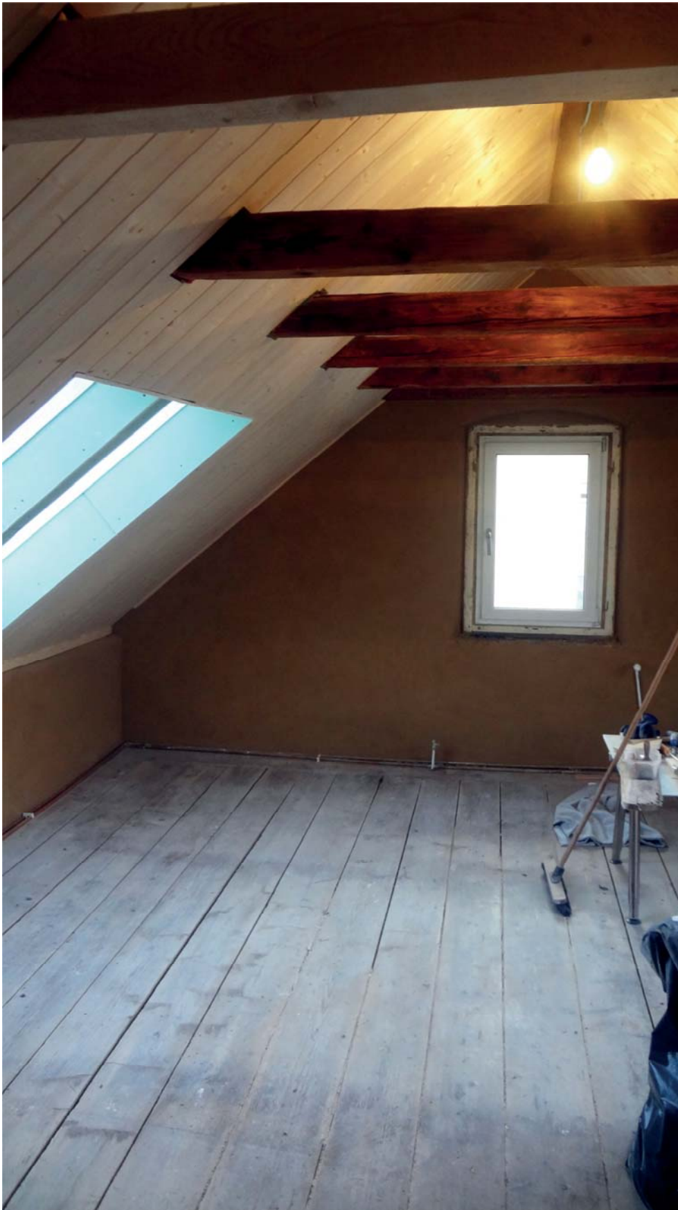
Abbildung 78 – Wohnraum im zweiten Obergeschoß während der Sanierung 2016; am Boden sind die Umrisse eines Bettes ersichtlich
