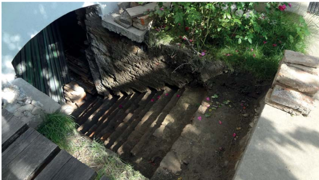
Abbildung 59 – Freigelegter als Schmutzeingang dienender direkter Kellerzugang
