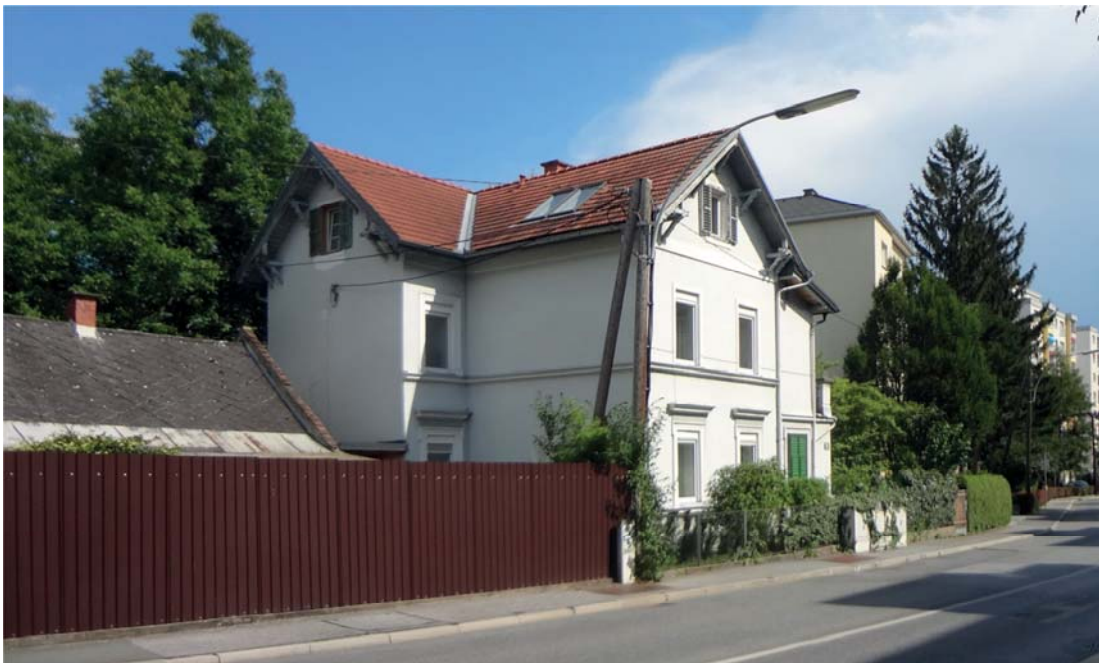
Abbildung 23 – Zustand der Villa im Jahr 2017, Ansicht Nord-West
