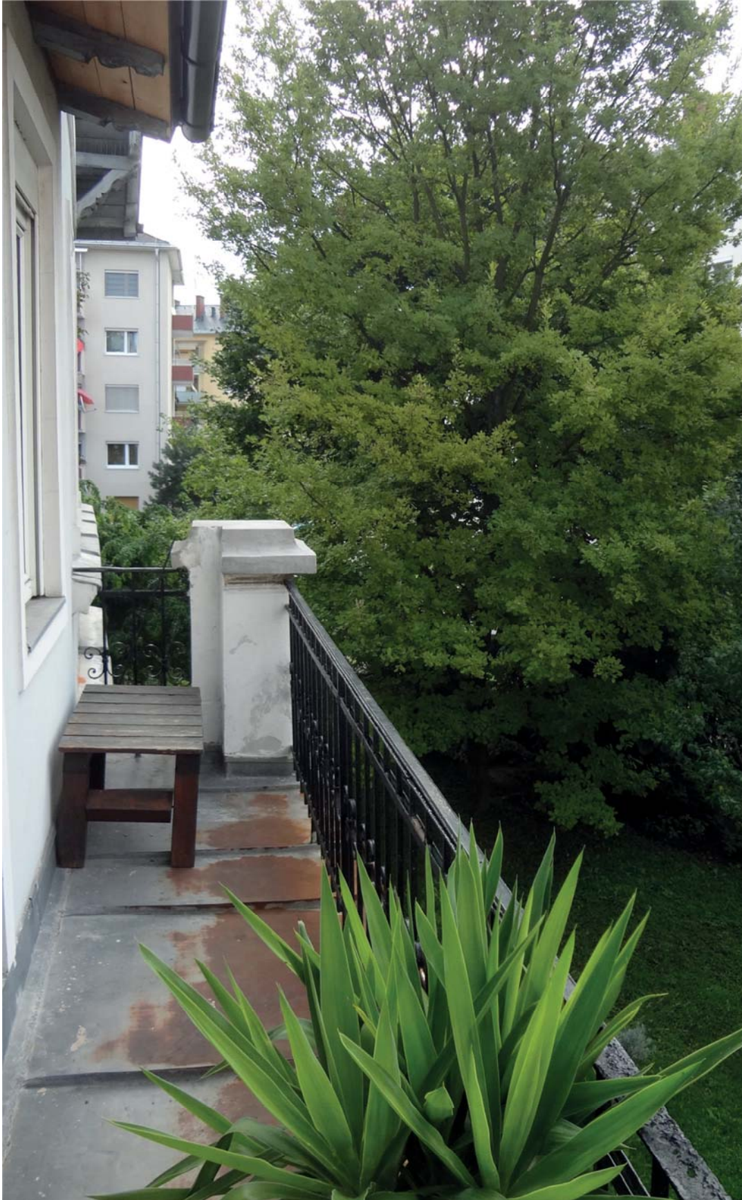
Abbildung 76 – Terrasse der Villa Hochstrasser
