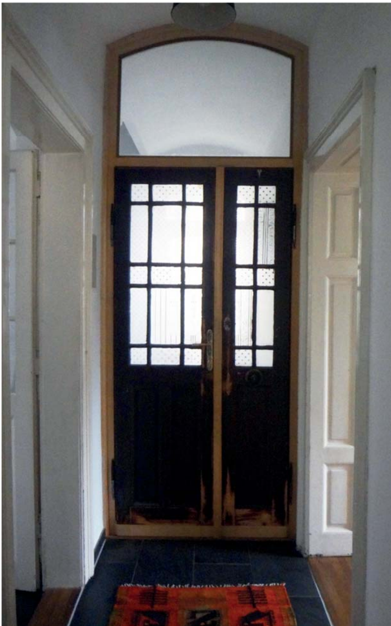
Abbildung 71 – Innenansicht der wiedereingebauten originalen Eingangstür im ersten Obergeschoß 2015
