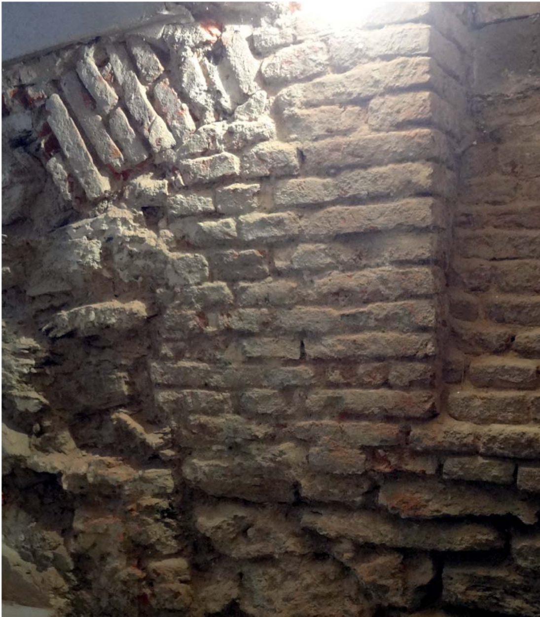
Abbildung 63 – Im Zugangsbereich des Kellers vom Stiegenhaus aus ist ein Bogenfragment des überformten früheren Wohnhauses zu sehen, ebenfalls unterscheiden sich die Bruchsteine in Konsistenz und Aussehen von jenen der in Folge des Villabaus errichteten Kellerbereiche.
