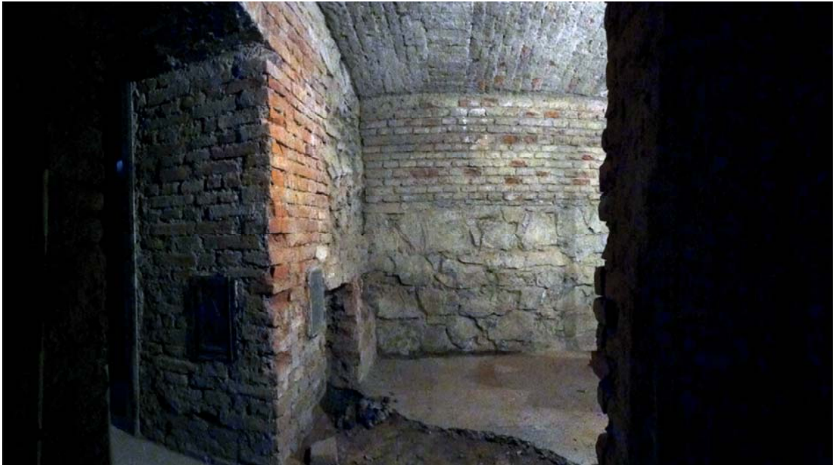
Abbildung 62 – Während der Kellersanierung in Richtung Waschküche blickend. Gut zu erkennen sind das Bruchsteinmauerwerk im unteren Bereich der Kelleraußenwand sowie der Anschluss des Kesselofens an den Schornsteinzug.
