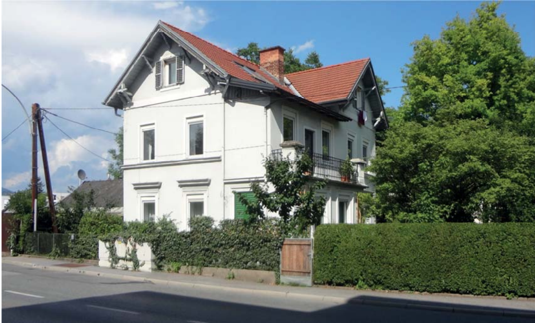
Abbildung 22 – Zustand der Villa im Jahr 2017, Ansicht Süd-West
