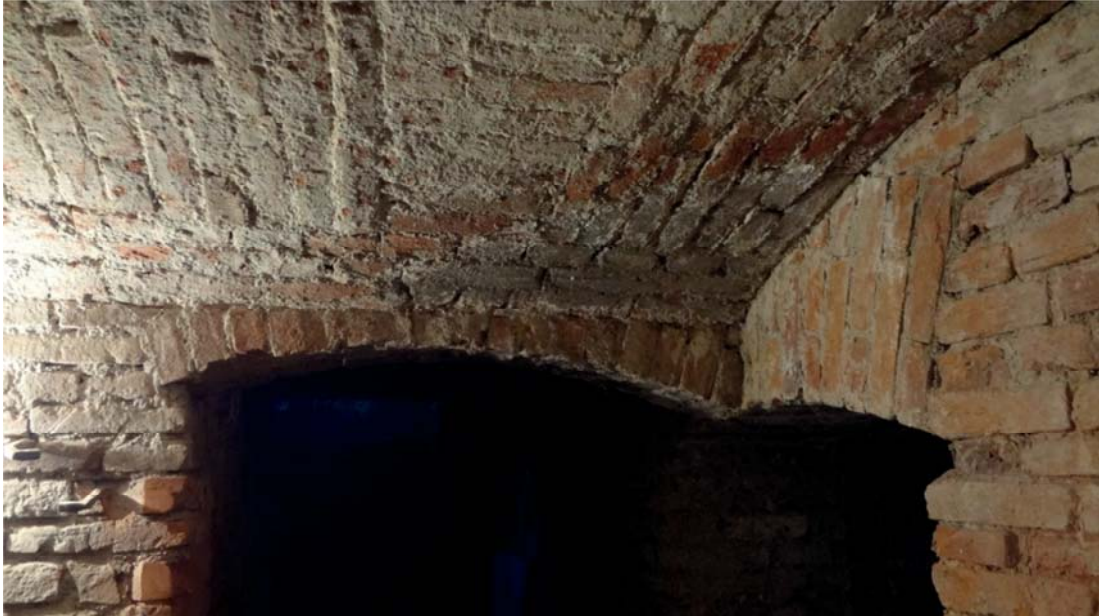
Abbildung 64 – Zwei Durchgangsbögen mit der Besonderheit, dass der linke Bogen die Last anstatt in die Wandscheibe in den rechten Bogen ableitet. Der rötliche Streifen an der Gewölbedecke zeigt die Position der früheren Trennwand zwischen Waschküche und Kellergang.
