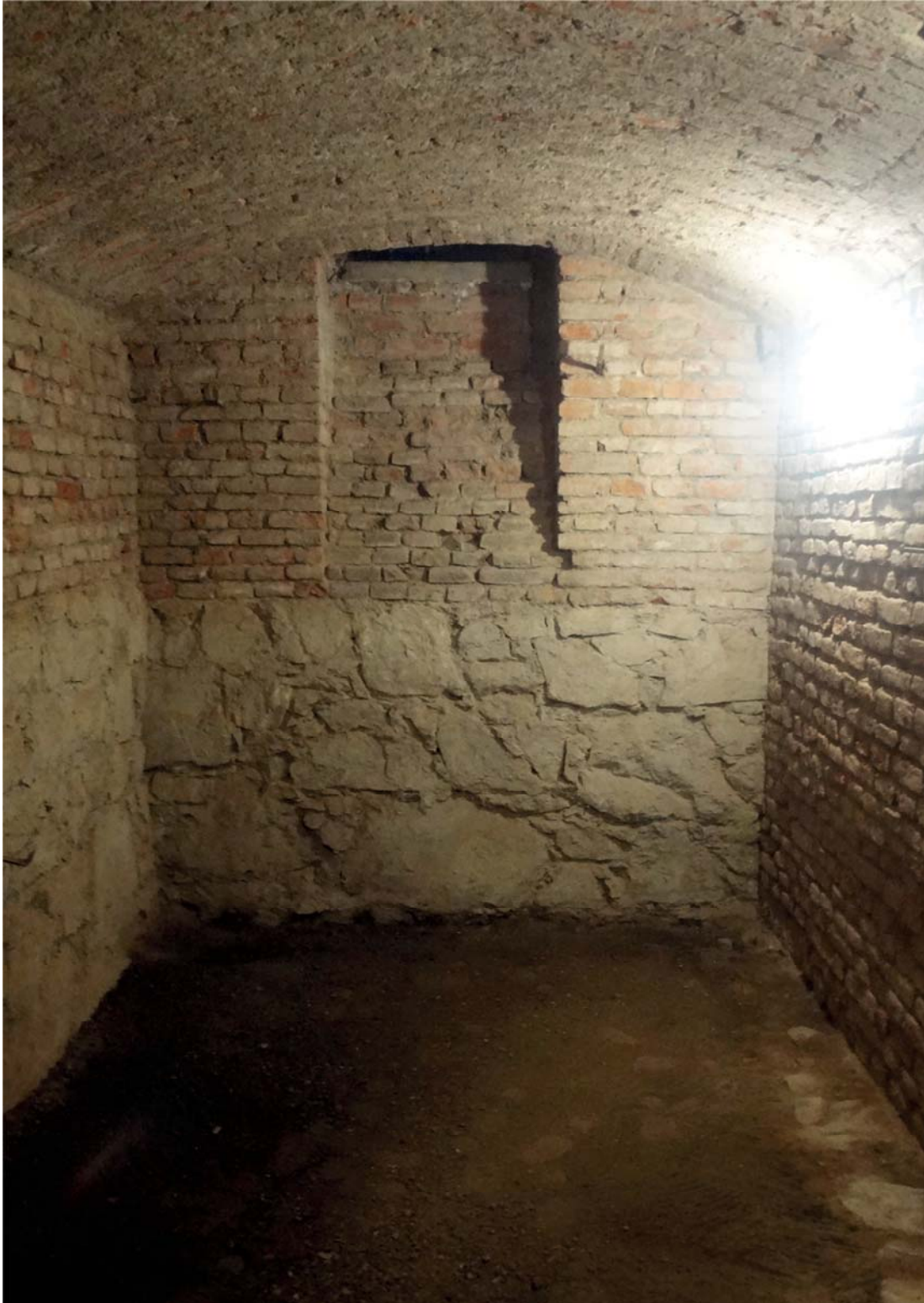
Abbildung 67 – Waschküche, Blick in Richtung Westen (Straßenseite) mit vollständig entferntem Wandputz und Betonboden. Rechts ist das Bankett der Innenmauer zu sehen.
