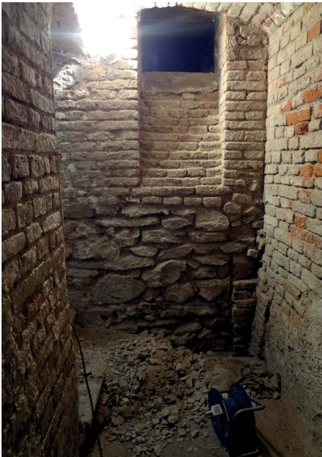
Abbildung 66 – Vorraum in Richtung Kellertreppe während der Stemmarbeiten zur Freilegung der Mauern
