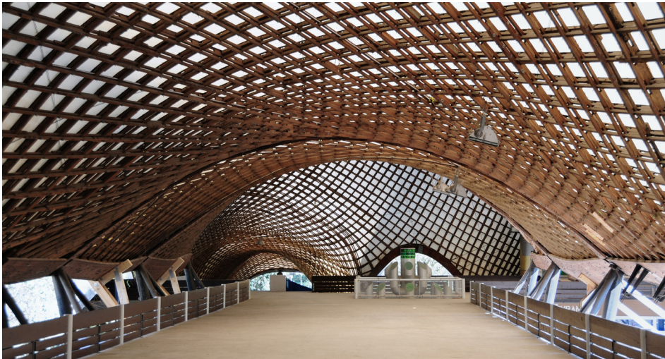
Abb.41: Frei Otto, Multihalle Mannheim 1975 als Paradebeispiel für eine gelungene Holzkonstruktion
