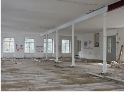
Abb.24: LendLoft vor dem Umbau
