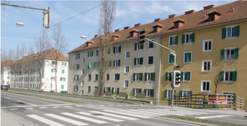
Abb.38: Triestersiedlung, Ansicht Triesterstrasse
