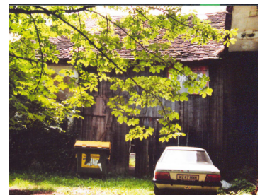
Abb. 24: Tor von außen, 1997
