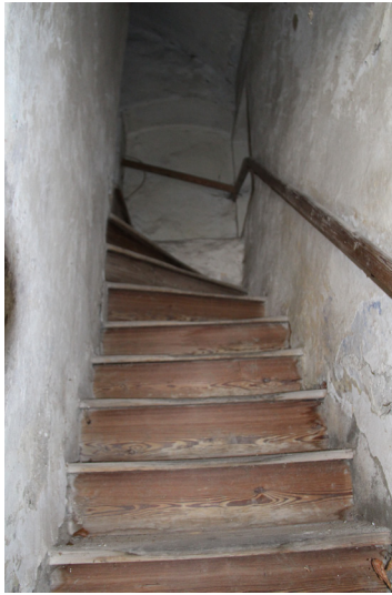
Treppe vom EG ins OG
