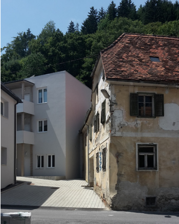
Feichtingerhof Straßenansicht mit Nachbargebäude
