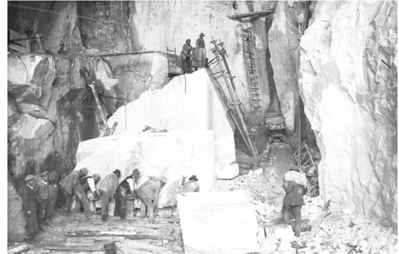
Abb. 4: Arbeiten im Weißwasserbruch in Laas
