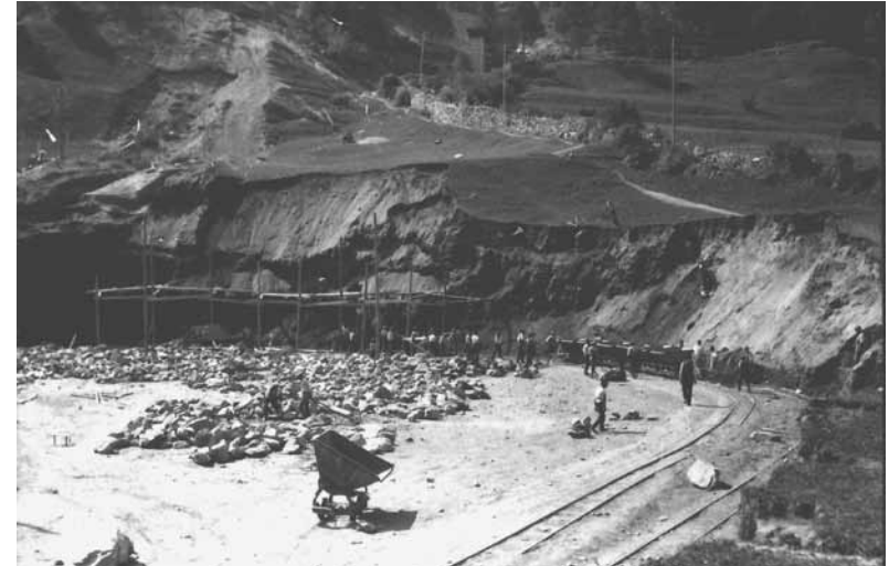
Abb. 7: Bau der Schrägseilbahn
