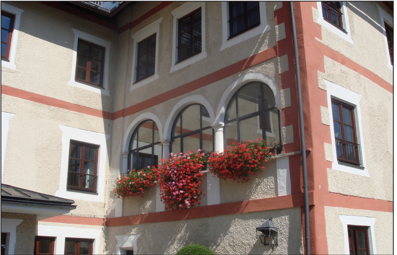
Abb. 10: Blick zur Loggia außen
