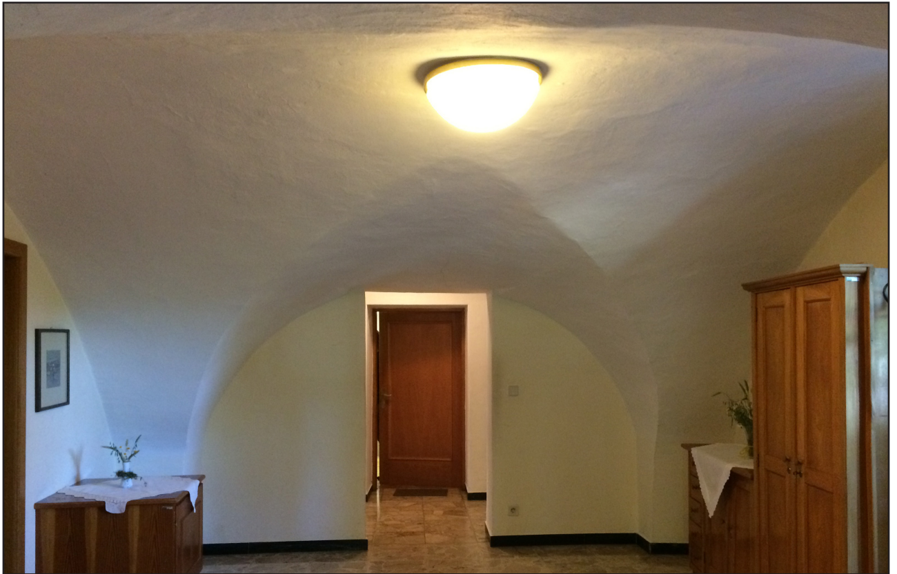
Abb. 07: Gewölbe im Wartebereich des Erdgeschosses
