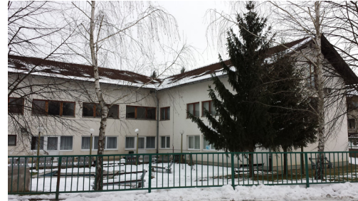
Slika 38. Pogled na Lječilište sa ulice Bild 38. Blick von der Straße auf den Kurort
