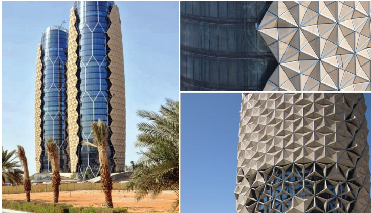
Abb.1.48: Die vorgesetzte Fassade der Al Bahar Towers von Aedas Architects schützt vor Überhitzung und Blendung
