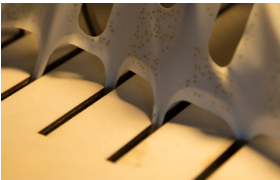
Abb.4.26: Ankerpunkte der Membran im Detail © Florian Voggeneder
