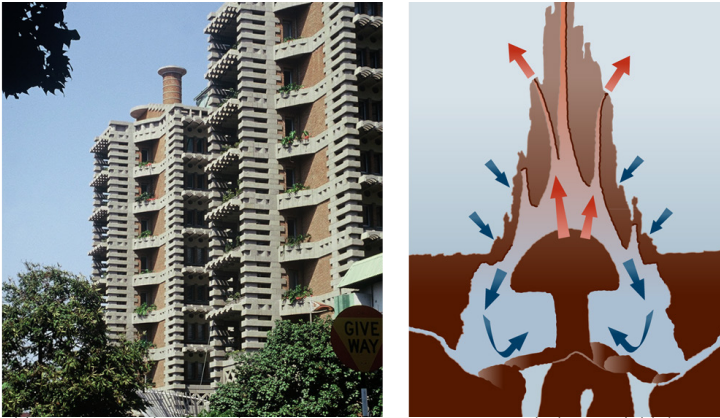
Abb.1.13: Das Einkaufs- und Bürozentrum Eastgate Centre nach dem Vorbild des Termitenbaus
