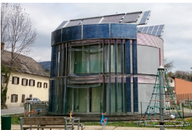
Abb.1.12: Das Geminihaus in Weiz ist ein Drehsolarhaus von Architekt Erwin Kaltenegger und funktioniert wie eine Sonnenblume
