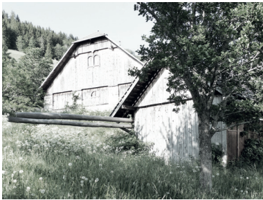
Abb. 17: Unterhiesgut, Wagenhütte NEU
