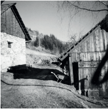
Abb. 13: vor 1988; Schmiede, Holzhütte
