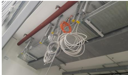
Abbildung 5-2: MC - Kabel fixiert
