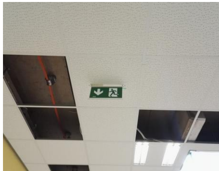
Abbildung 6-52: MG – Notleuchte mit Piktogramm
