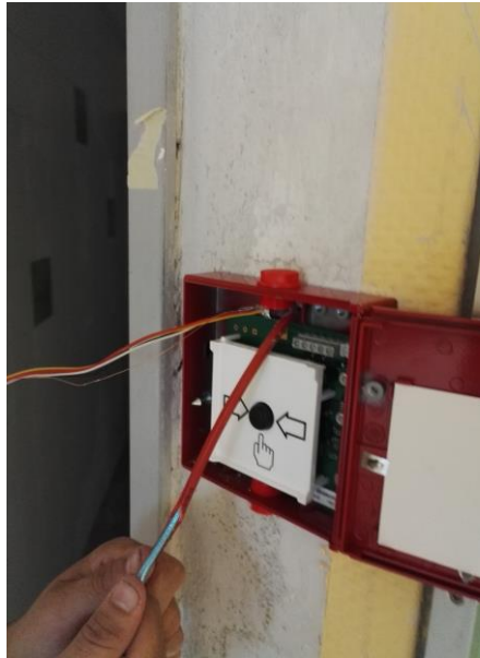
Abbildung 6-35: MG – Montage Druckknopfmelder
