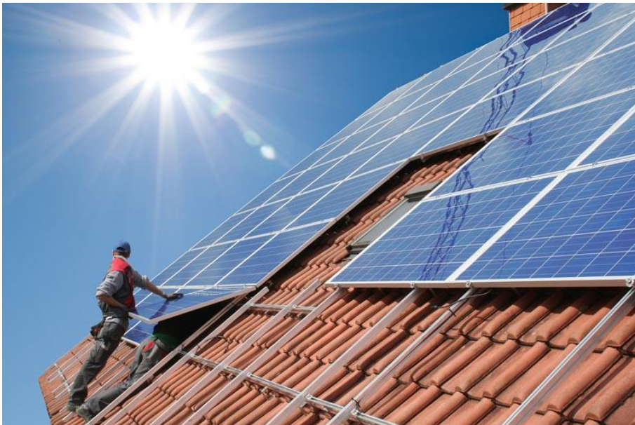
Abbildung 2-15: Montage Photovoltaik 45
