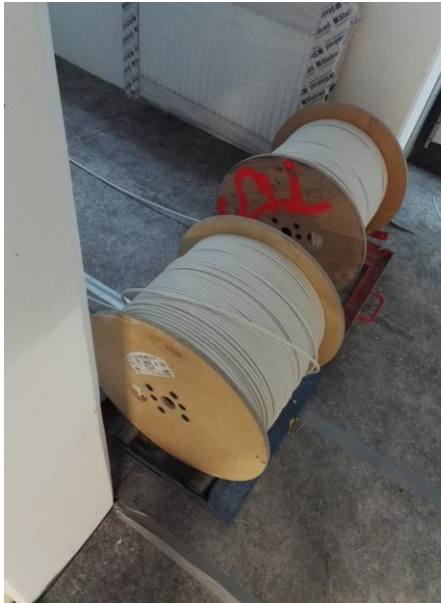
Abbildung 5-24: MC - Kaberolle IT-Übertragungskabel
