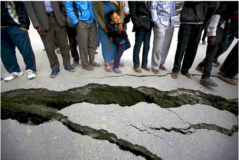
Abb.11: Ein Riss in der Strasse, der durch das Erdbeben verursacht wurde, Bhaktapur, 04/ 2015
