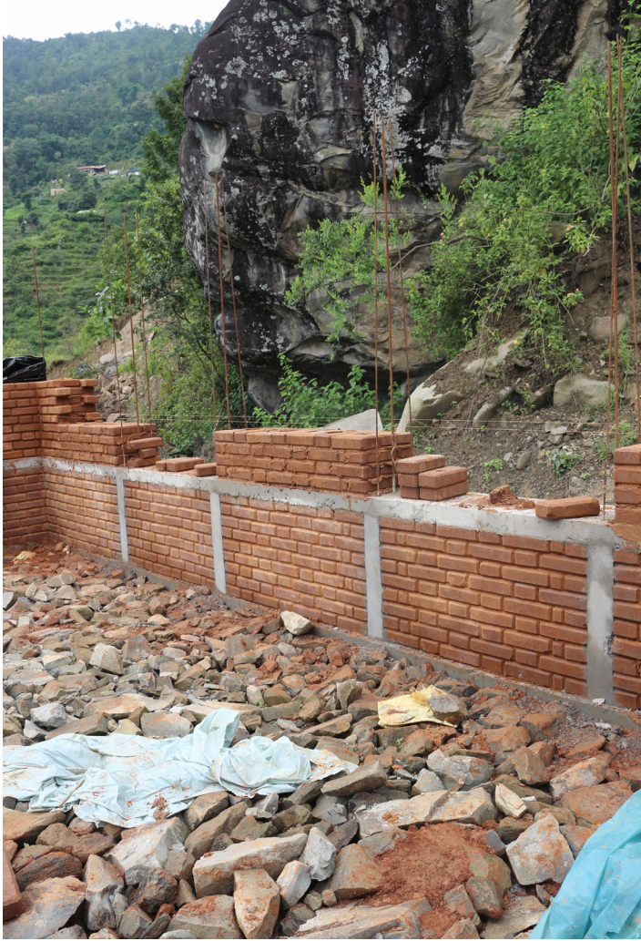
Abb. 114: Abari, Saraswati Secondary School, Dulikhel, Bau des Mauerwerks aus Lehmziegel, 09/ 2016
