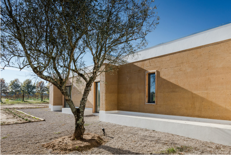
Abb. 41: Blaanc Architekten, Vineyard house, Montijo, Portugal, 2012, Ansicht, Stampflehmkonstruktion mit Flachdach
