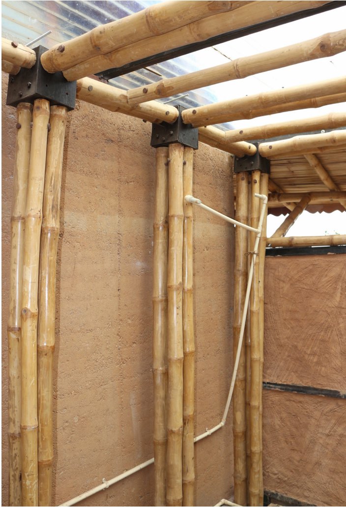
Abb.107: Abari, Dulikhel Learning Center, Dulikhel, Stützen aus je 4 Bambusstäben und Knoten aus Metall, 10/ 2016
