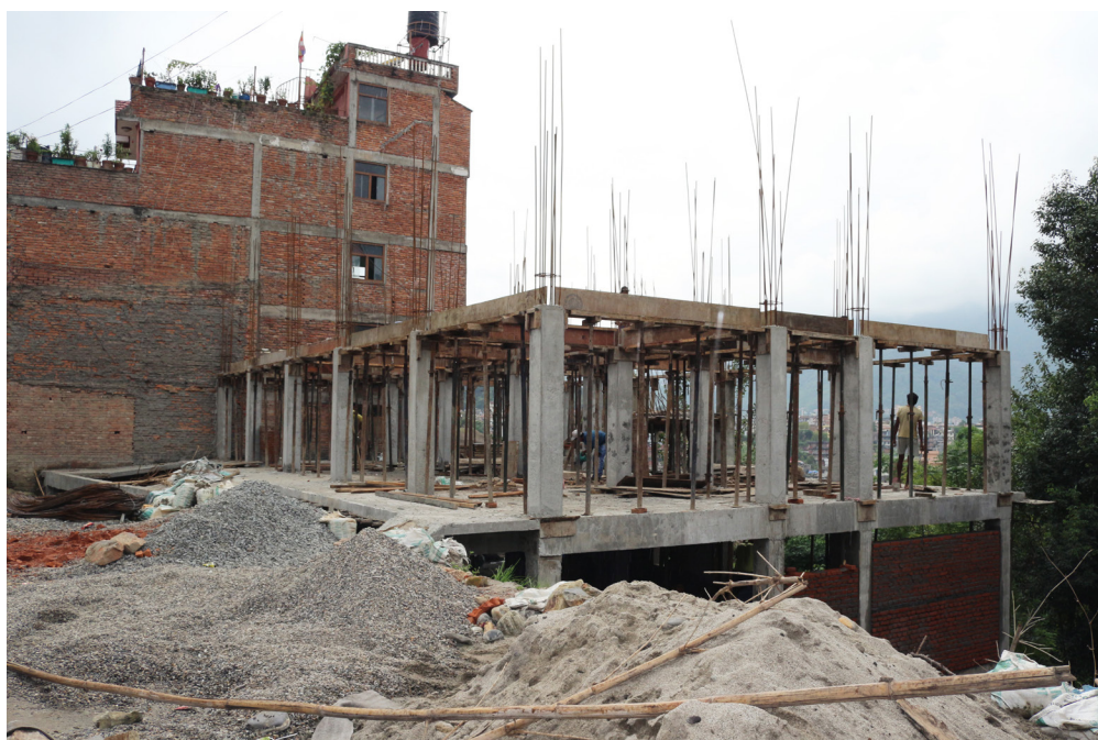
Abb. 73: Weitere Baustelle, mehrgeschossiges Wohnhaus aus Stahlbeton und gebrannten Ziegel, 09/ 2016
