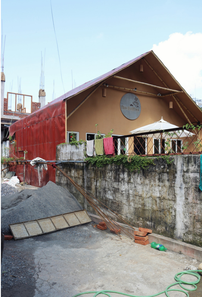
Abb.118: Abari, The Coffee, Pokhara, Sicht auf die Dachkonstruktion, 10/2016
