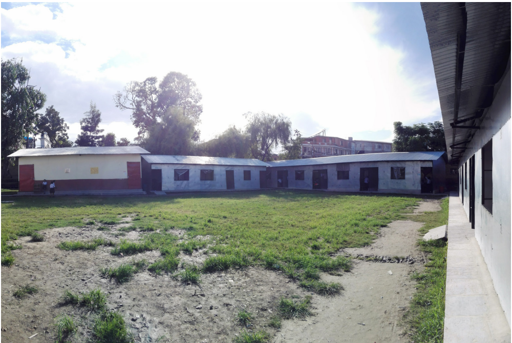
Abb. 74: Lernzentrum der „Patan Higher Secondary School“, Kathmandu, 09/ 2016, Sicht auf den Schulhof mit umliegenden Klassenzimmern, Die Schule wurde nach dem Erdbeben 2015 als semi-permanente Installation errichtet
