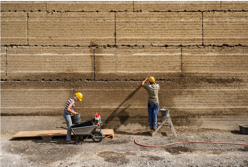
Abb. 21: Herzog&deMeuron, Ricola Kräuterzentrum, Laufen, Schweiz, 2014, das Gebäude besteht aus Lehmblöcke
