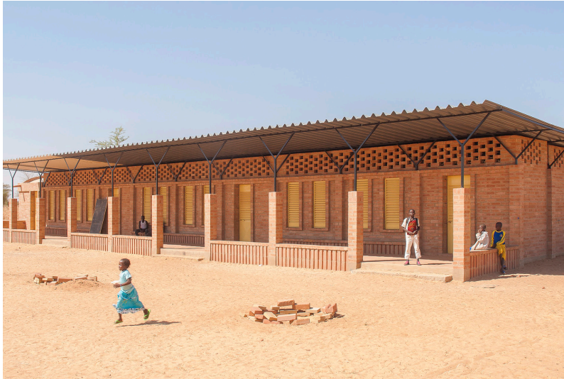
Abb. 34: Levs Architekten, Gangouroubouro Primary School, Mali, Afrika, 2013, Ansicht von Süden, Ziegel aus lokal hergestellten HCEB (hydraulic compressed earth blocks)
