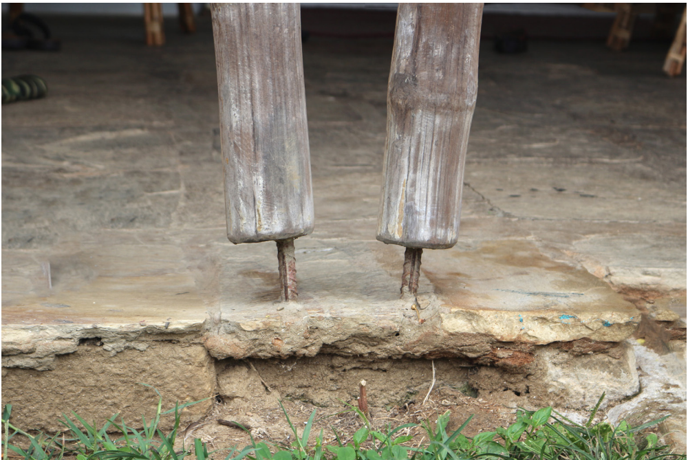
Abb. 95: Bambusstütze auf Metallfuss um vor der Witterung zu schützen, 25/09/2016
