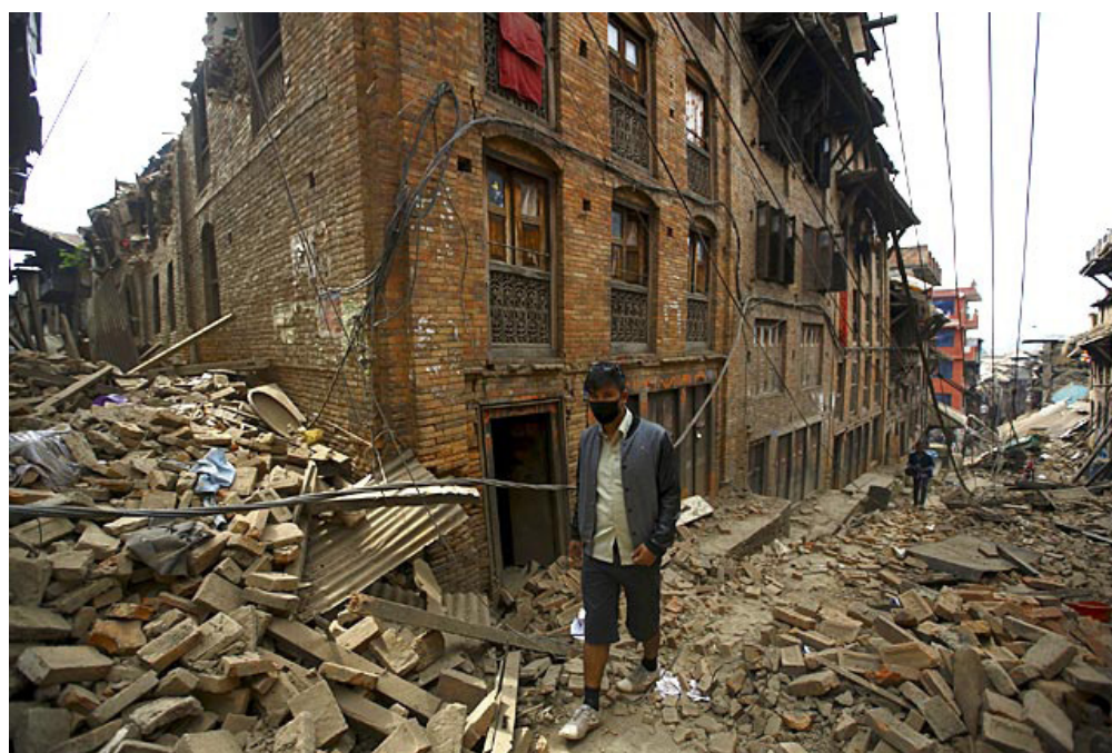
Abb.12: Mann geht an einem zerstörten Haus entlang, Bhaktapur, 04/ 2015
