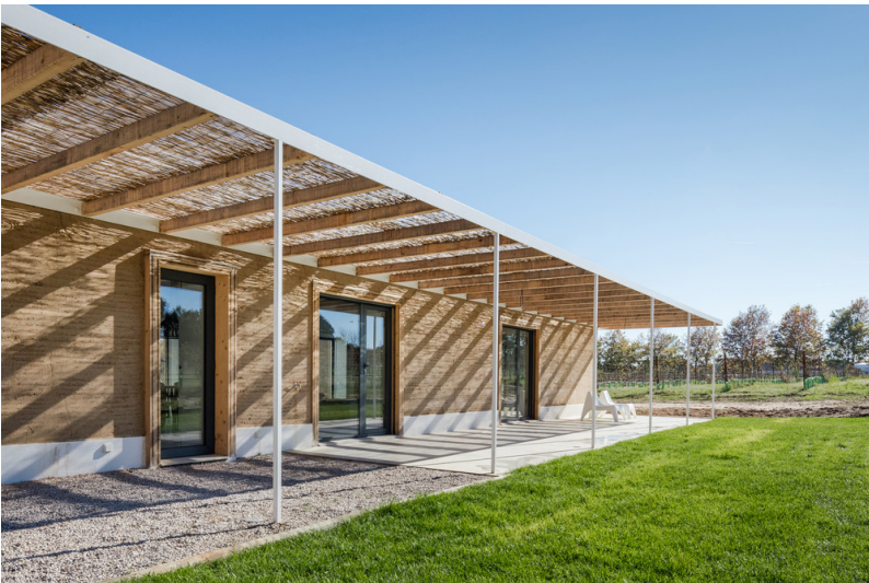
Abb. 42: Blaanc Architekten, Vineyard house, Montijo, Portugal, 2012, Ansicht
