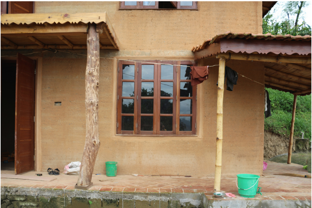
Abb.104: Abari, Dulikhel Learning Center, Dulikhel, Säulen aus Bambus und Holz ,10/2016
