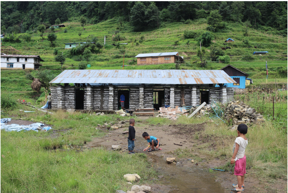
Abb. 86: Bau der neuen Grundschule aus „Earthbags“, 15/09/2016
