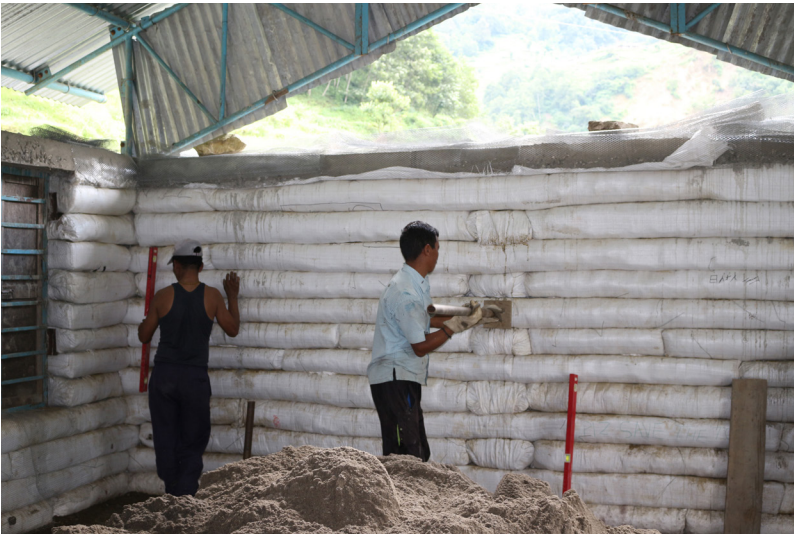
Abb. 37: NGO „Good Earth Nepal“, Grundschule während den Bauarbeiten, Phulping, Nepal, 09/ 2016, Bewohner des Dorfes beim stampfen der Erdsäcke
