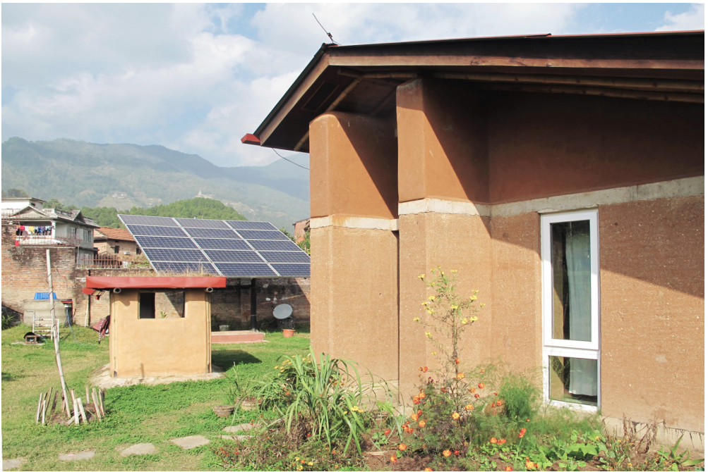
Abb.93: Eingangssituation und Solaranlage; 25/09/2016
