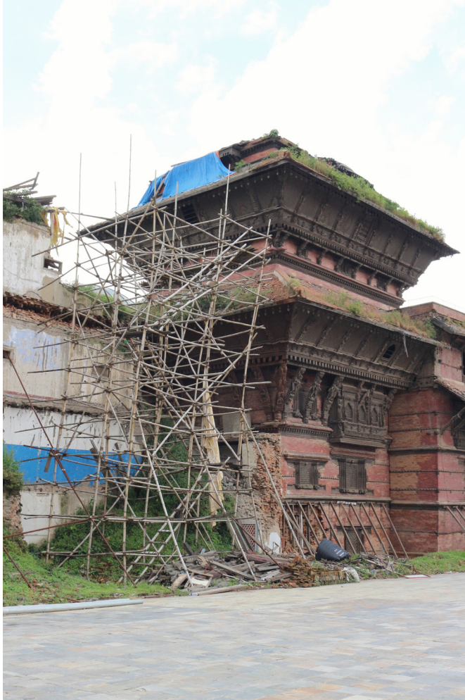
Abb. 71: Gerüst aus Bambus, Durbar Platz, 09/2016 09/2016
