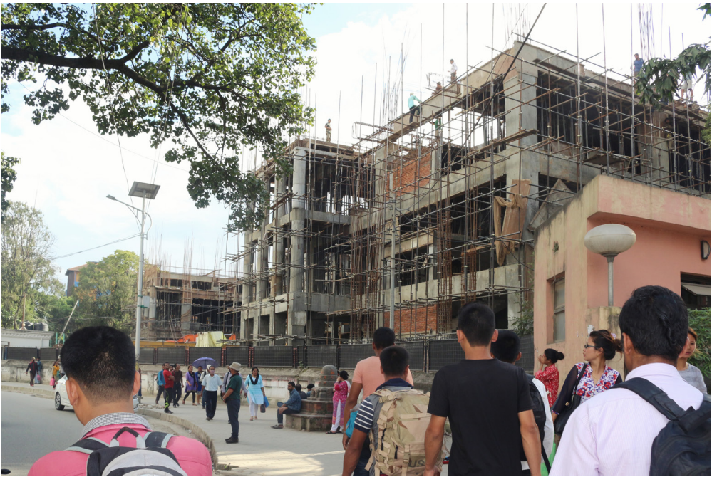
Abb. 72: Baustelle, mehrgeschossiges Gebäudes aus Stahlbeton und gebrannten Ziegel, 09/ 2016
