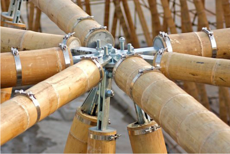
Abb. 56: Markus Heinsdorff, „German-Chinese House“, Shanghai World Expo, 2010, Metallverbindung von 10 Bambusstäben
