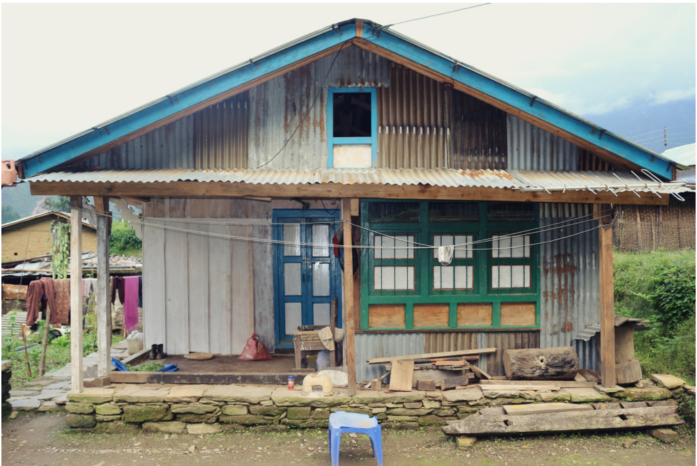
Abb. 80: Einfamilienhaus aus Holz, Wellblech und Steinfundament, welches nach dem Erdbeben neu errichtet wurde, 14/09/2016
