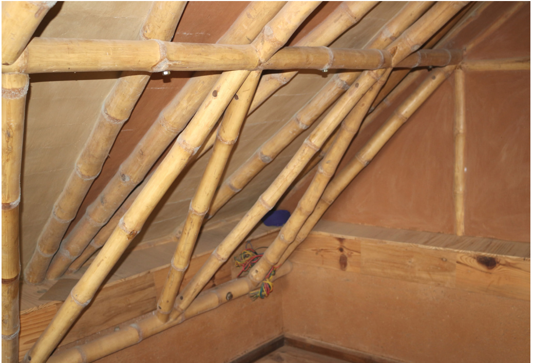
Abb.106: Abari, Dulikhel Learning Center, Dulikhel, Dachausbau, Dachstuhl aus Bambuskonstruktion, 10/ 2016
