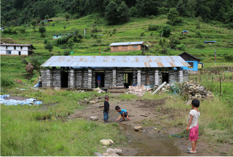
Abb. 36: NGO „Good Earth Nepal“, Grundschule während den Bauarbeiten, Phulping, Nepal, 09/ 2016, Ansicht von Süden
