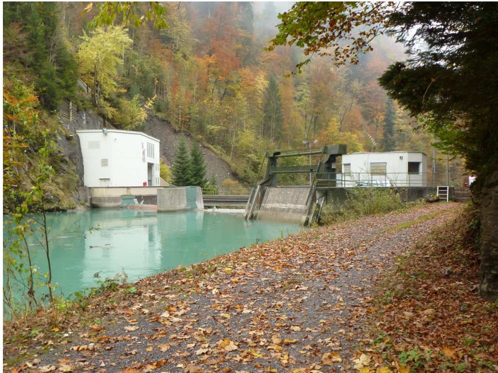
Figure 8.6: Existing weir structure - 3 - 23.12.2012 - Vorarlberger Kraftwerke AG [2013]
