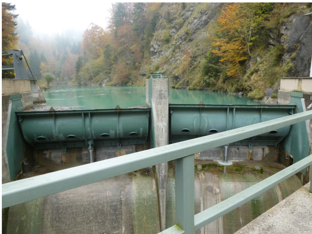
Figure 8.7: Existing weir structure - 4 - 23.12.2012 - Vorarlberger Kraftwerke AG [2013]
