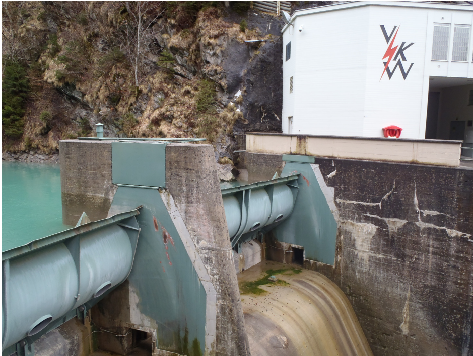
Figure 8.4: Existing weir structure - 1 - 19.03.2013 - Vorarlberger Kraftwerke AG [2013]
