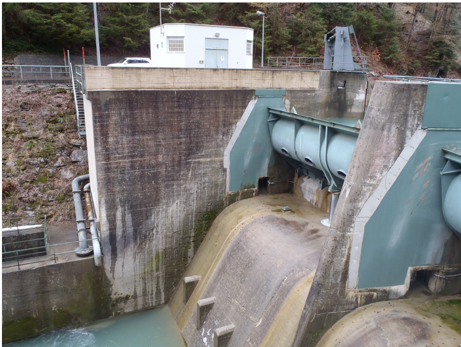
Figure 8.5: Existing weir structure - 2 - 19.03.2013 - Vorarlberger Kraftwerke AG [2013]
