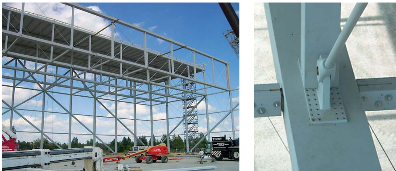
Abb. 2.7: Anwendungsbeispiele als Fachwerkknoten (aus [34])
