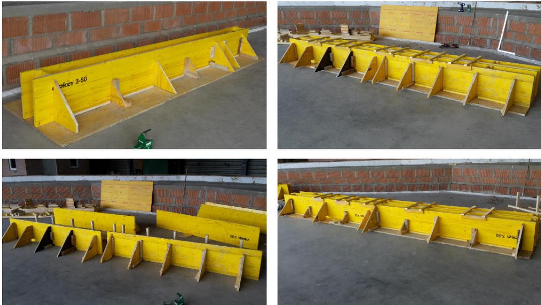
**Abb. 4.7.:** Herstellung der Schalung
