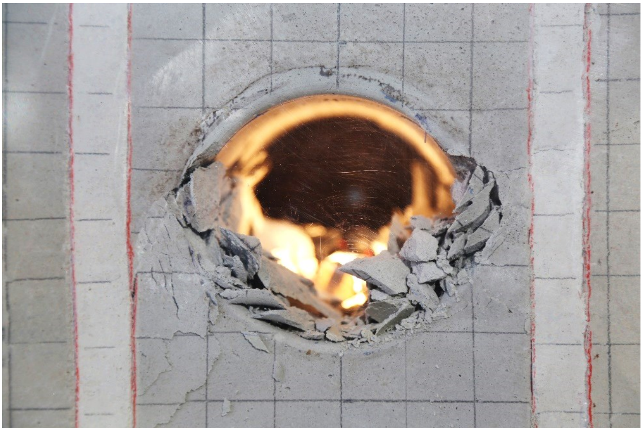
Abbildung 14 MV2 – Endzustand mit Bruchzonen an der rechten und linken Ulme, Harnischflächen (rot)
