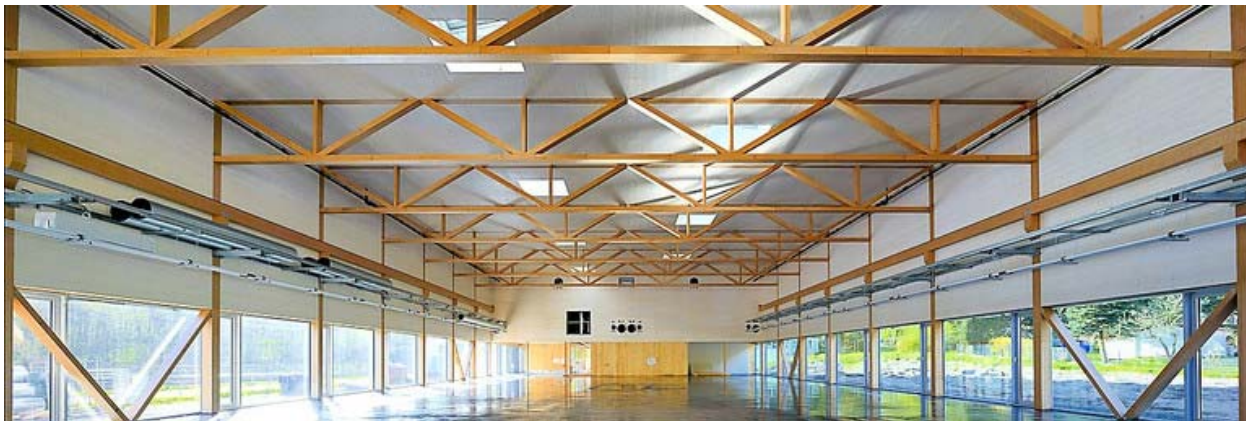
Abbildung 2-2: Hallentragwerk aus Buchenurnierschichtholz (BauBuche) (Peters 2016)
