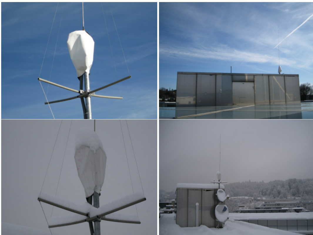
Abbildung 4.7: Die linke obere Abbildung zeigt die Schutz-Ummantelung des Vorverstärkers und die Verstreibungen samt Abspannungen der Antenne, rechts davon erkennt man die Befestigung am Dach-Container mit GPS- und VLF-Antenne. Die beiden Grafiken darunter sind Aufnahmen bei winterlichen Bedingungen, ein Szenario für nur wenige Tage pro Jahr. Die Kabeldurchführung in den Serverraum ist mehrfach gegen äußere Einflüsse geschützt.
